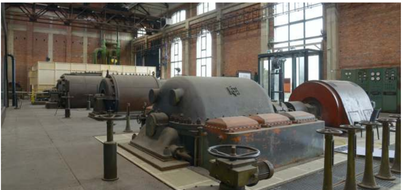
Renovierte Maschinenhalle der Zeche Zolder. (2015)
