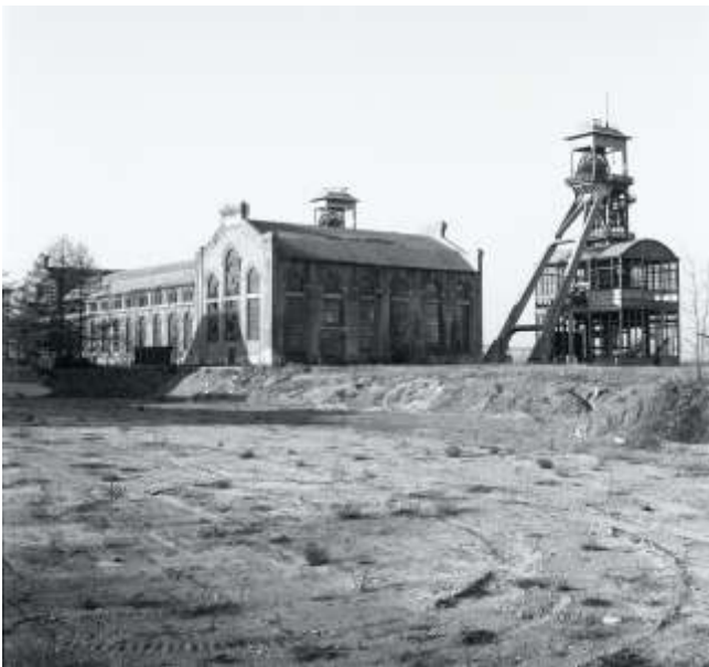
Verdichter in der Maschinenhalle der Zeche Eisden. (1990)
