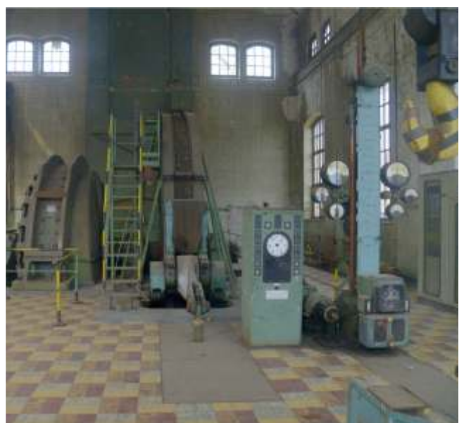
Eine der erhaltenen Fördermaschine vom Bergwerke Beringen. Diese Maschine wird jedoch nicht im Rahmen von Führungen gezeigt. (2015)
