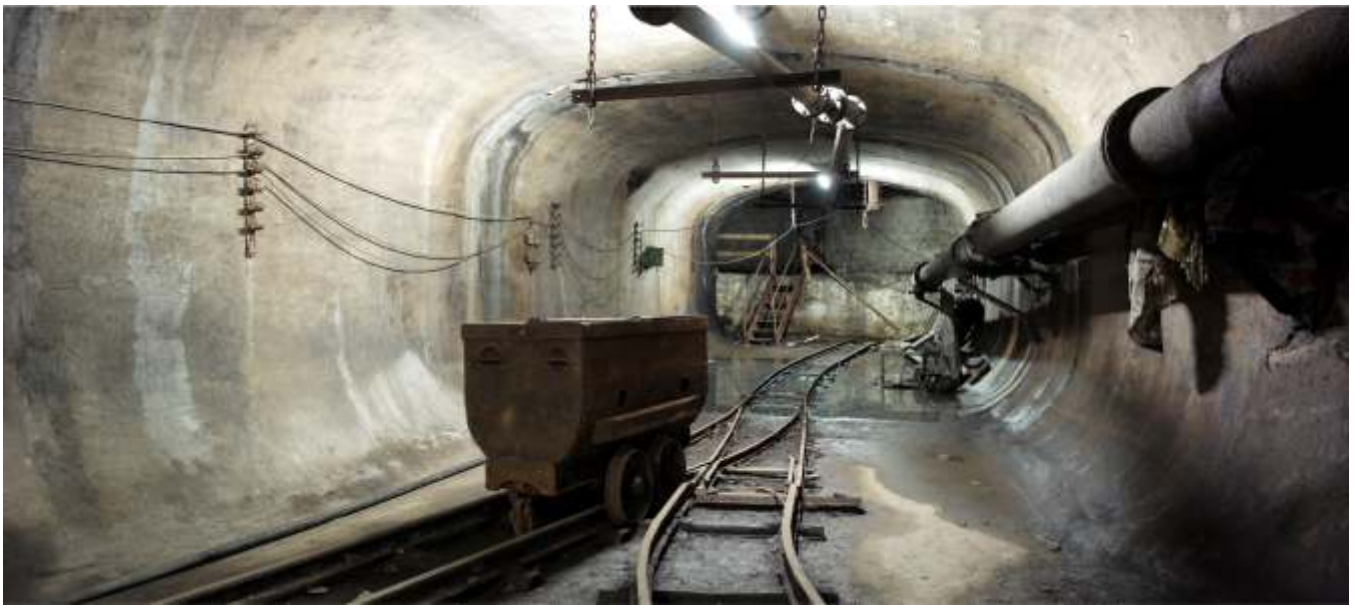
Lüftertunnel auf der Zeche Waterschei (2015)
