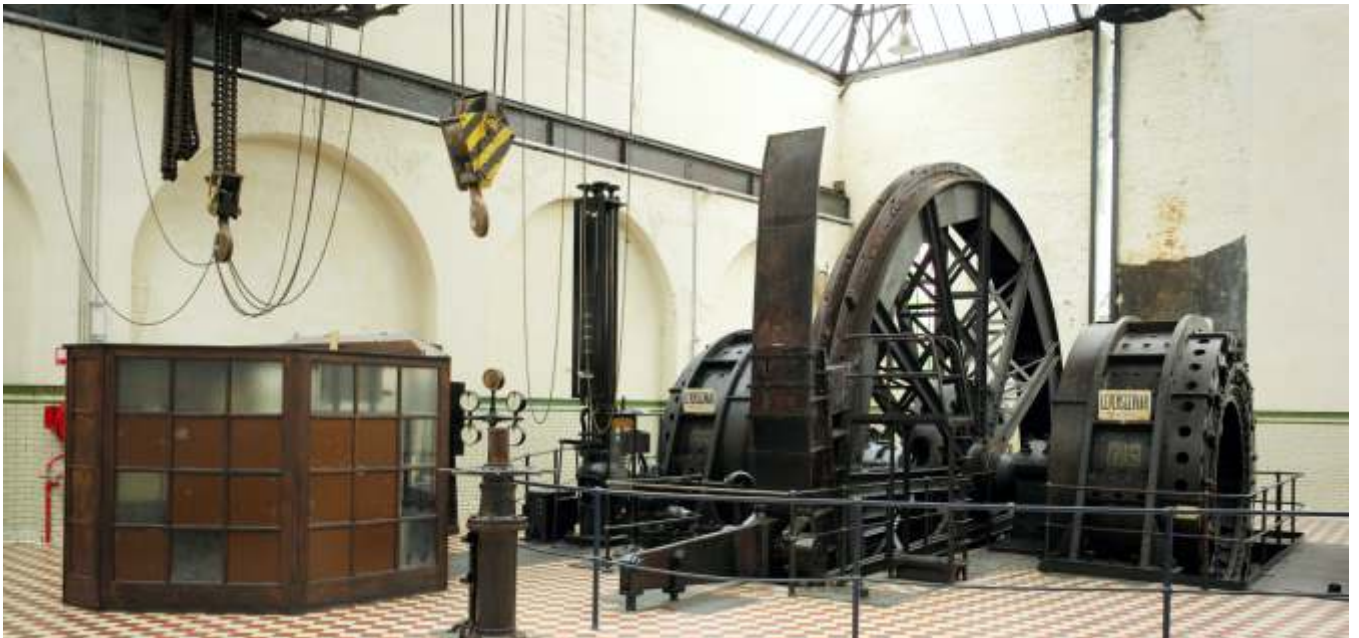
Renovierte Fördermaschine auf der Zeche Winterslag (2014)
