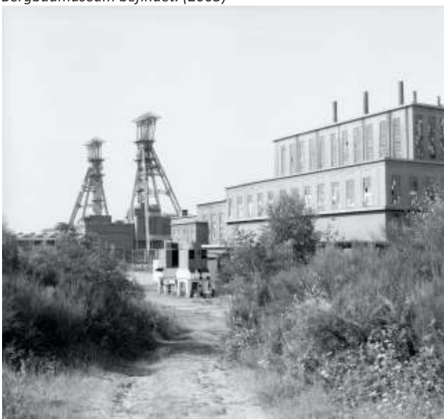
Rückansicht der Zeche Houthalen. Das Kraftwerk wurde abgebrochen, die Fördergerüste existieren ohne Führungsgerüste noch heute. (1992)
