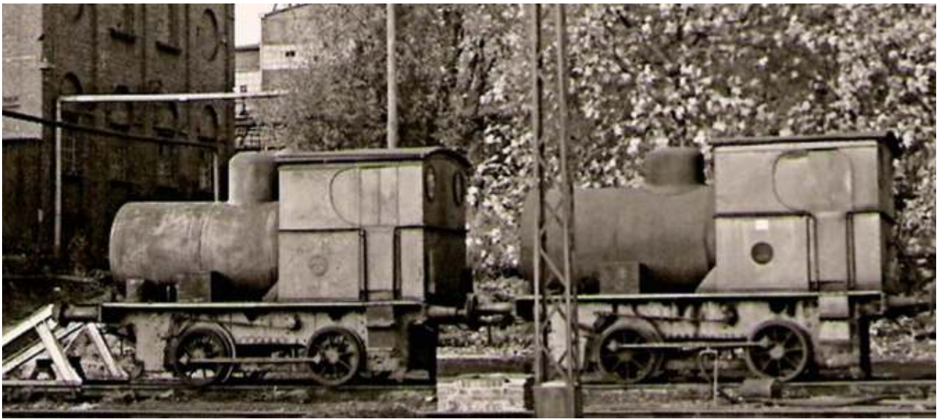
Die beiden Dampfspeicherloks vor der Kulisse des Neuschachtes auf der Schachanlage Maria-Hauptschacht im unteren Bahnhof (Foto Helmut Roel)
