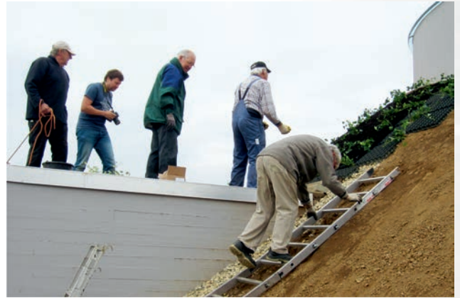
Bild 34: Einbau der Rasengitter und Efeupflanzen 26.9.2014
