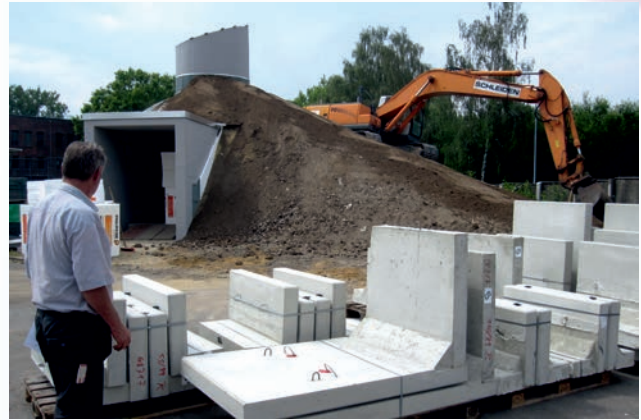
Bild 16: die L-Steine sind angeliefert und der Hügel nimmt Gestalt an 24.6.2014
