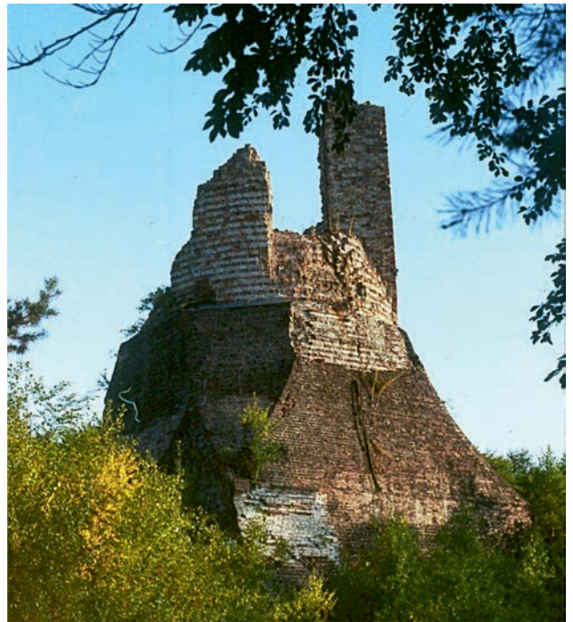
Reste Kamin "Langer Emil" 134,6 m Sprengung Oktober 1961
