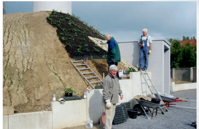
Bild 35: die letzten Rasengitter werden in steilsten Bereich des Kapellenhügels eingebaut 30.9.2014
