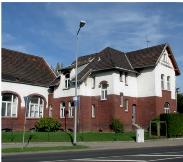
Herzogenrather Straße 100 Blick vom Energeticon auf den Verwaltungstrakt
