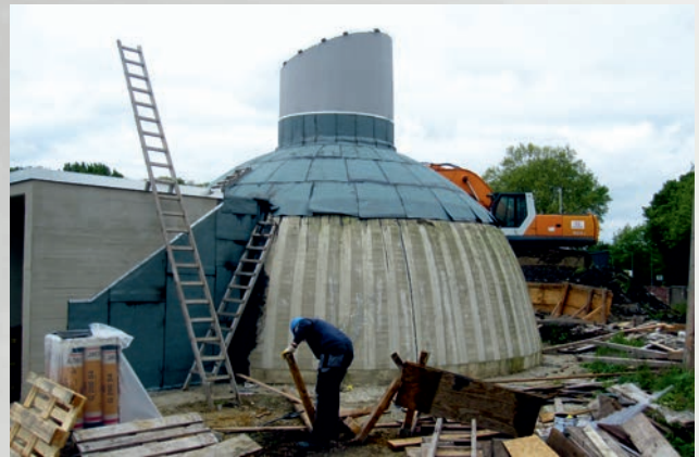
Bild 6: die Kuppel erstmals ohne Gerüst 15.5.2014
