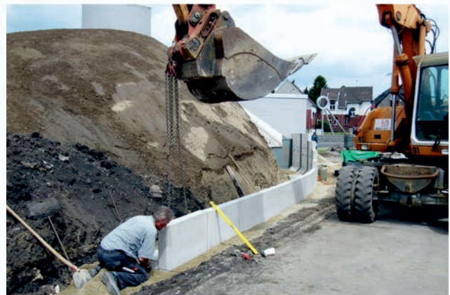
Bild 17: das Setzen der L-Steine 30.6.2014
