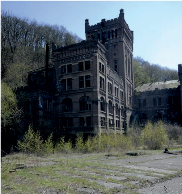
Turmförderanlage vom Schacht 1 aus dem Jahr 1907 (2013)
