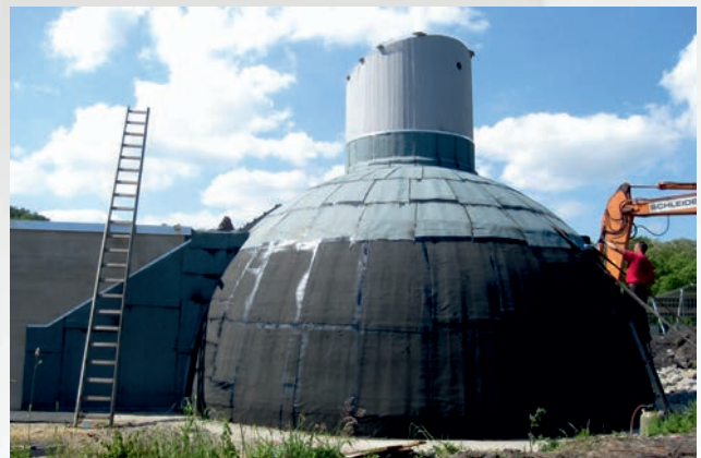
Bild 7: Oberer Teil der Kuppel fertig gestellt unterer Teil erste Dichtbahnen 19.5.2014
