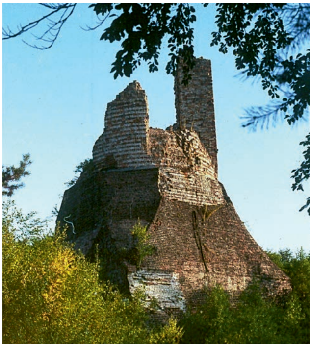
Reste Kamin "Langer Emil" 134,6 m Sprengung Oktober 1961
