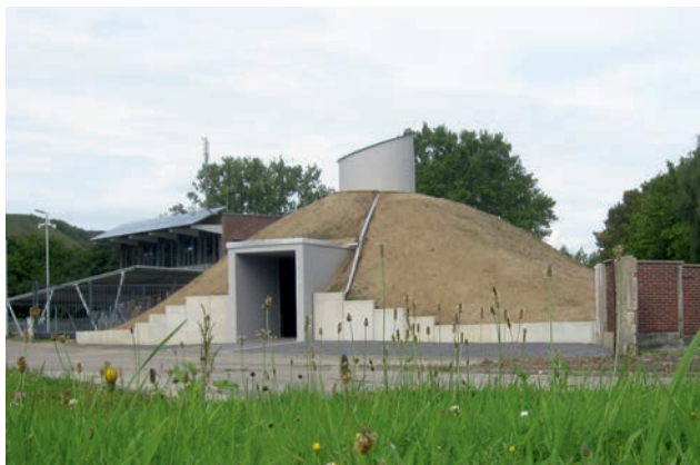
Bild 33: die Barbarakapelle ist befreit von allen Bauzäunen und Baucontainern 25.8.2014
