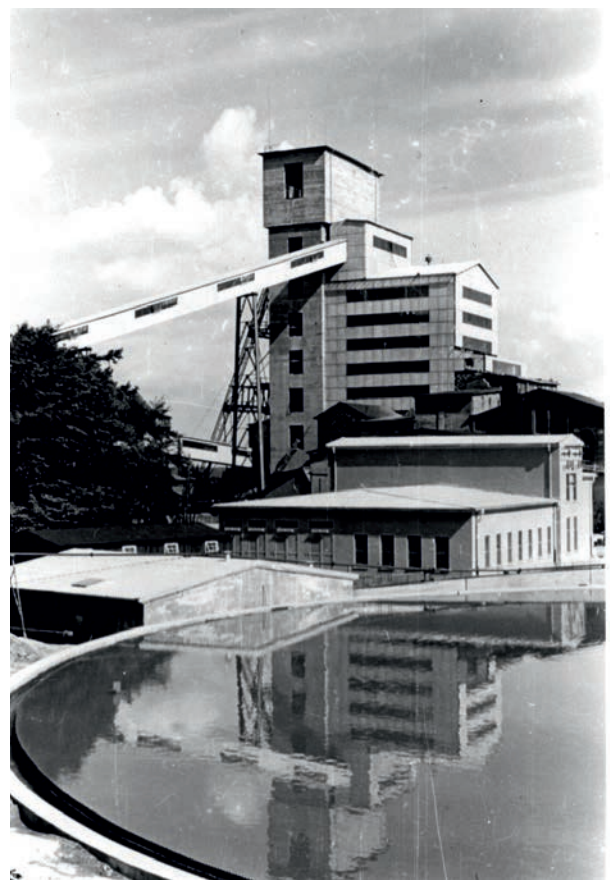
Förderturm mit 60 m Eindicker (Sprengung September 1980)
