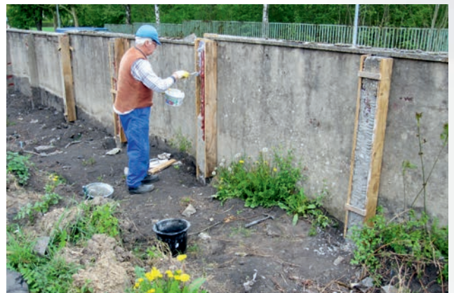
Bild 37: Reparaturarbeiten an der vorhandenen Mauer 22.4.2014
