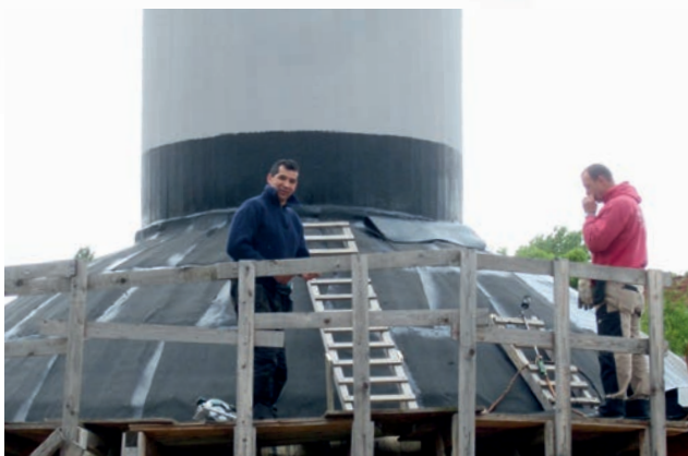
Bild 5: Beginn der Abdichtungsarbeiten an der Kuppel 6.5.2014
