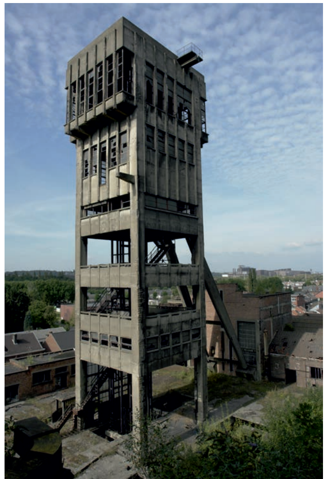
Blick auf den Schacht 3, zuerst besaß der Turm eine Turmfördermaschine, später wurde die Fördermaschine im Gebäude rechts aufgestellt und der Turm wurde mit einer Strebe ergänzt. (2008)
