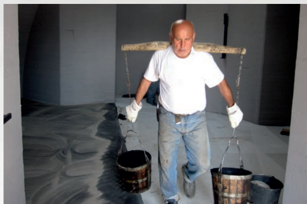
Bild 13: der Gussasphalt wird auf den Kapellenboden aufgebracht 23.7.2014
