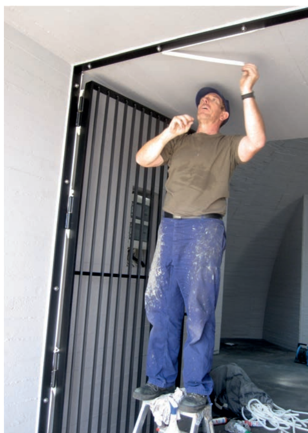
Bild 24: Josef Rosenbaum versiegelt den Torrahmen 26.7.2014
