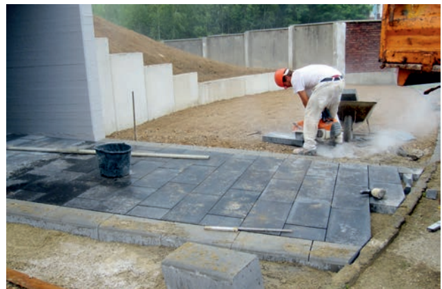
Bild 26: Verlegen der Betonsteine im Kapelleneingang 8.8.2014
