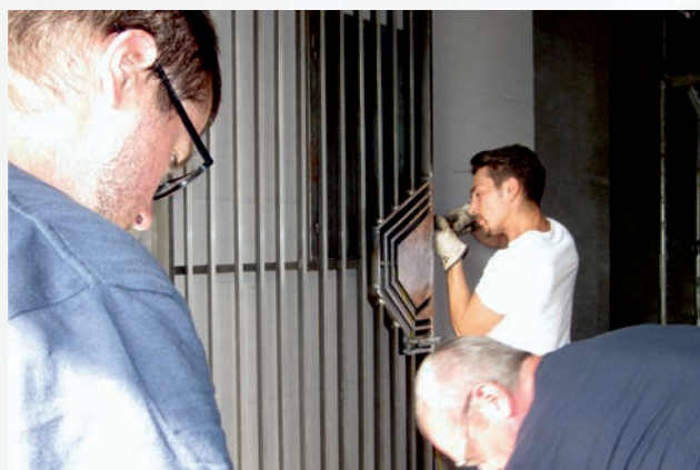
Bild 11: Probeeinbau des Tores vor der Pulverbeschichtung 10.6.2014
