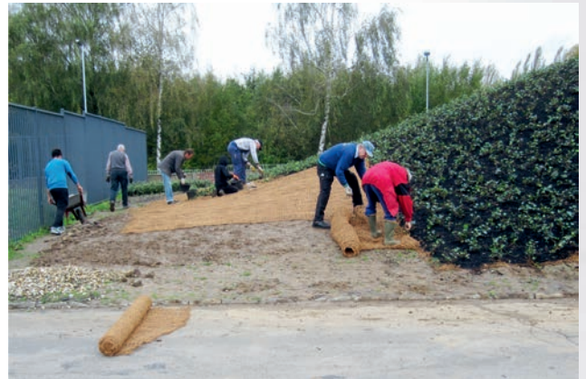
Bild 36: die letzten von 2 500 Efeu-Pflanzen werden in Kokosfasergewebe eingesetzt 20.10.2014
