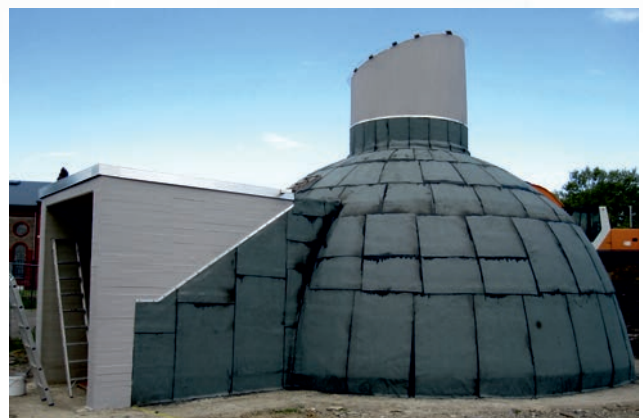
Bild 8: gesamte Kuppel und Eingang abgedichtet 22.5.2014
