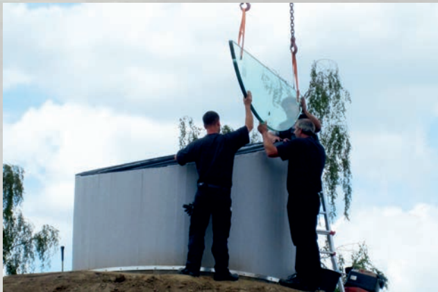
Bild 3: Einbau der Glasscheibe am 7.7.2014
