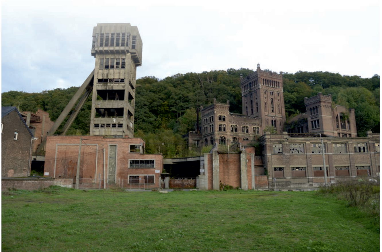
Blick auf die Schachthanlage 1/3 von der Wiese aus auf der früher die Kohlenaufbereitung stand. (2014)
