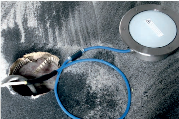
Bild 14: Einbau der Bodenleuchten 24./25.7.2014
