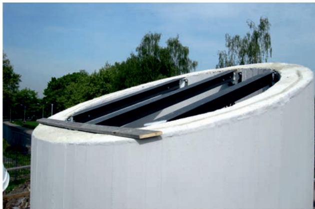
Bild 1: Unterstüztungsträger für die Glasscheibe ist seit 14.4.2014 fertig
