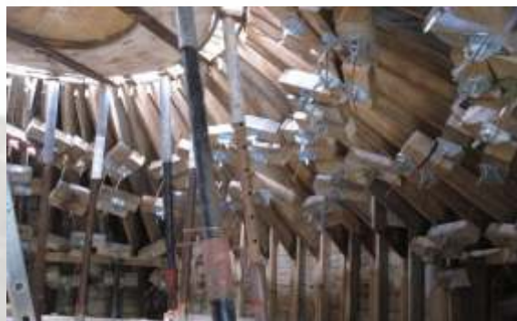
Die Verspannung der Schalung im Inneren
