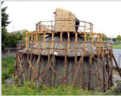
Letzte Schararbeiten am Lichtschacht September 2013
