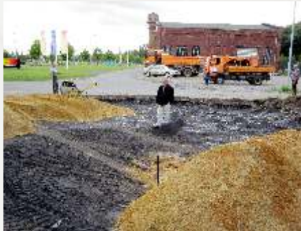
Der Baugrund zur Barbarakapelle wird vorbereitet, Juli 2011
