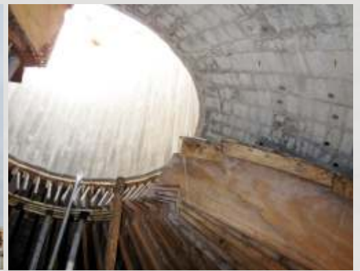
die ersten Elemente der Innenschalung wurden entfernt am 22.10.2013
