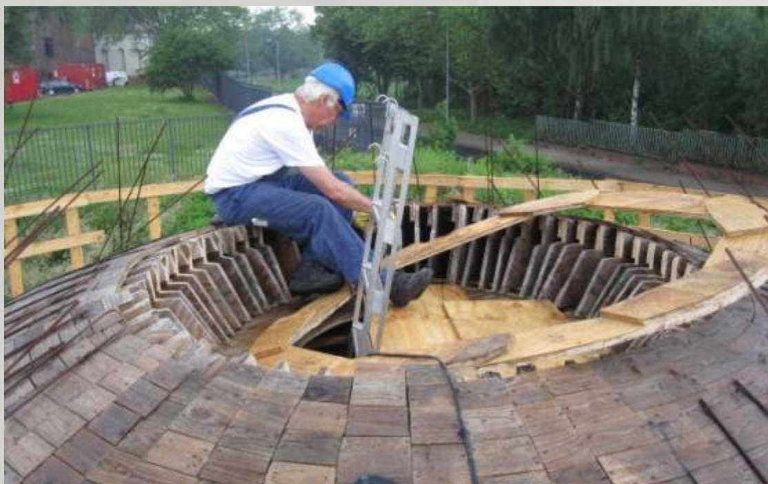
Fritz Schaffrath bearbeitet den Übergang von der Kuppel zum Lichtschacht
