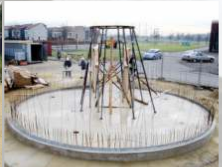
Beginn der Schalarbeiten am 25.01.2012
