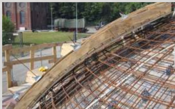
Die fertige Bewehrung und erstes Teil der Außenschalung zur oberen Kuppelhälfte
