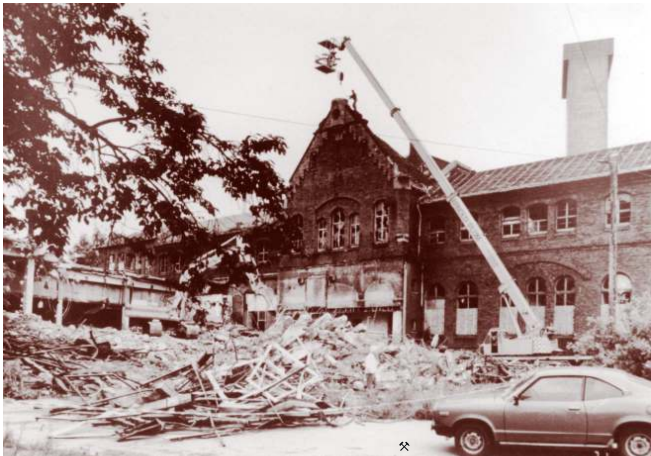
Abriss des Zechenhauses - Juli 1987
