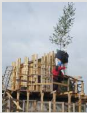
Lichtschacht ist fertig betoniert, der Richtbaum gesetzt am 10.10.2013
