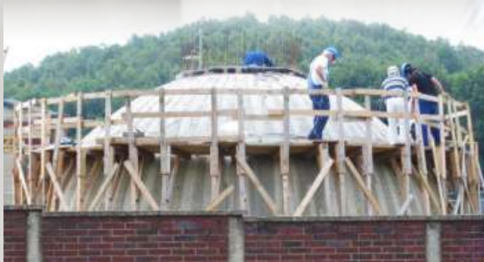
Die Kuppel ist ausgeschalt, Blick von der Herzogenrather Strasse am 02.09.2013
