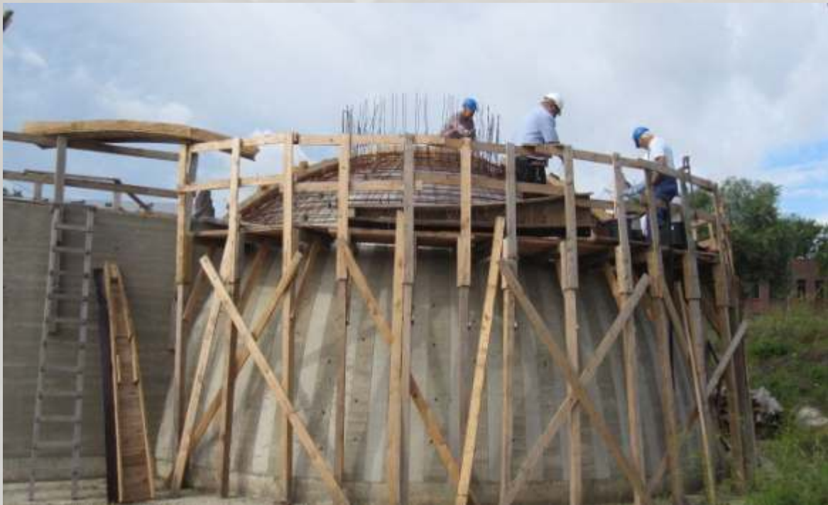
Arbeitsbühne für die obere Kuppelhälfte mit Michael Wijnandts, Fritz Schaffrath und Leo Widdeler
