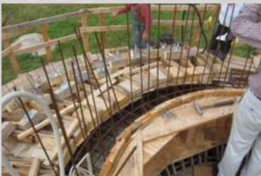
Letzte Handgriffe vor dem Betonieren
