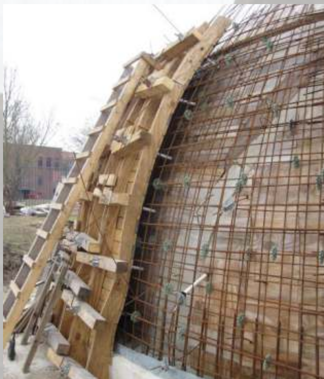
Beginn der Außenschalung zur unteren Kuppelhälfte
