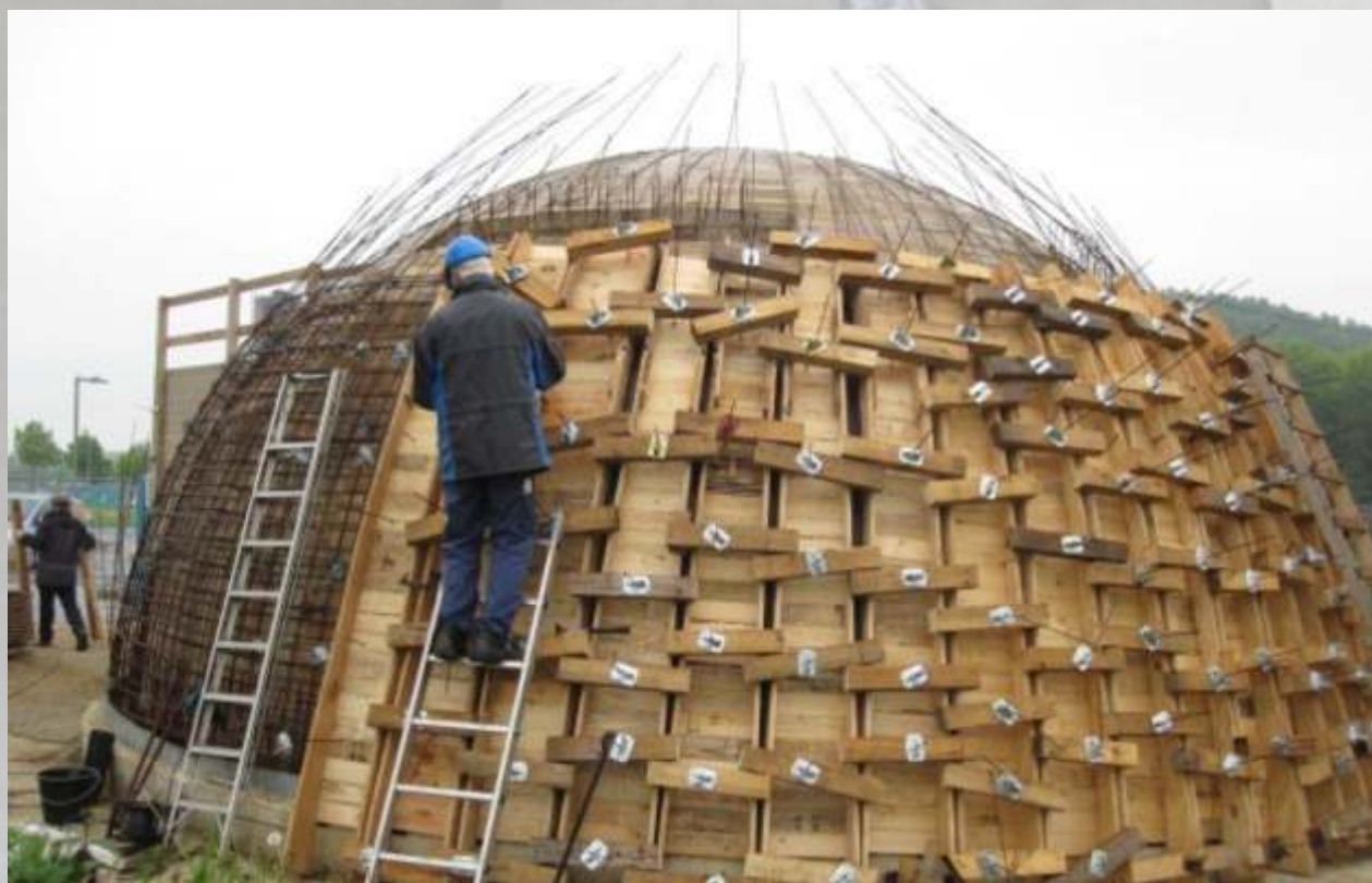
Die Außenschalung der unteren Kuppelhälfte ist fast fertig, Mai 2013
