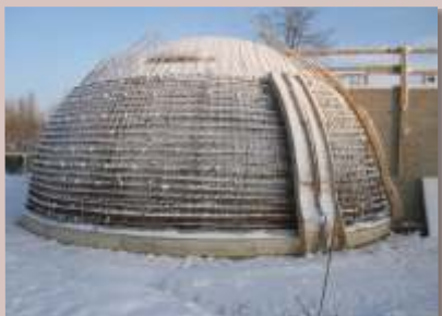
BARBARAKAPELLE Zwei Jahre nach Spatenstich
