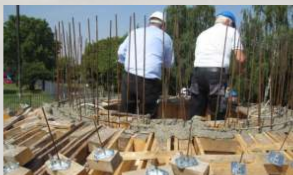
Die Kuppel ist fertig betoniert
