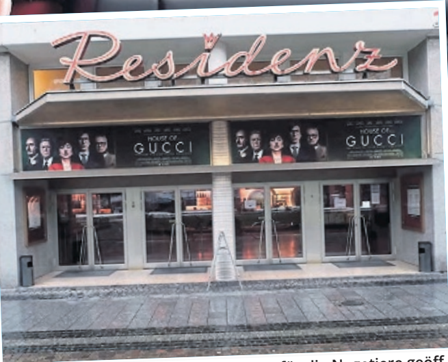
Durch Bauarbeiten sind Schlupflöcher für die Nagetiere geöffnet worden, wodurch sie ins Residenz einzogen. Foto: Grönert
