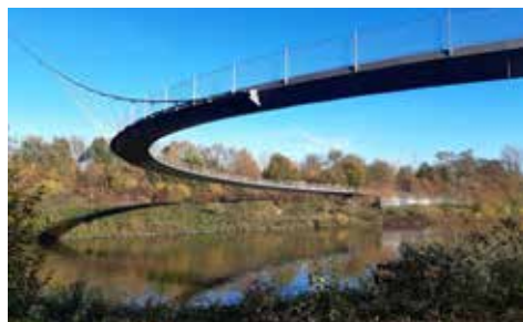
Fahrradbrücke über den Rhein-Herne-Kanal beim Hafen Grimberg
