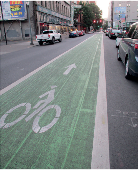
Die grün eingefärbte Fahrbahn beschränkt den Autoverkehr auf eine Fahrbahn und zwei Parkstreifen.
