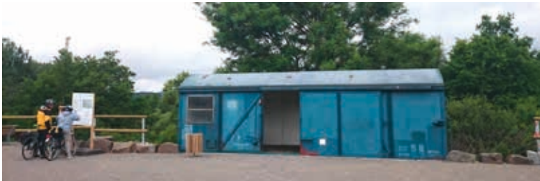
Der alte Waggon hat einen neuen Zweck: Er ist jetzt eine Schutzhütte.
