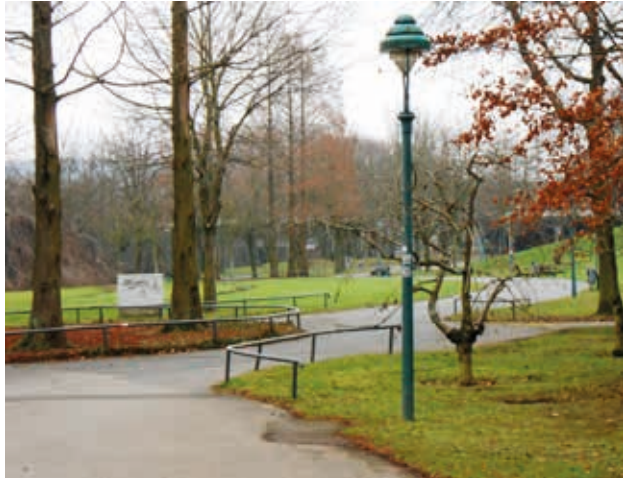
Engstelle am Japanischen Garten: Die Laterne ist defekt, die unauffälligen „Markierungen“ dienen kaum der Sicherung des Radfahrens in der Dunkelheit.
