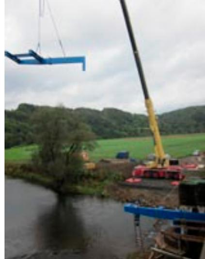
*Schwerstarbeit: Mit Großkränen wurden die Elemente der Fahrradbrücken über die Sieg eingesetzt*
