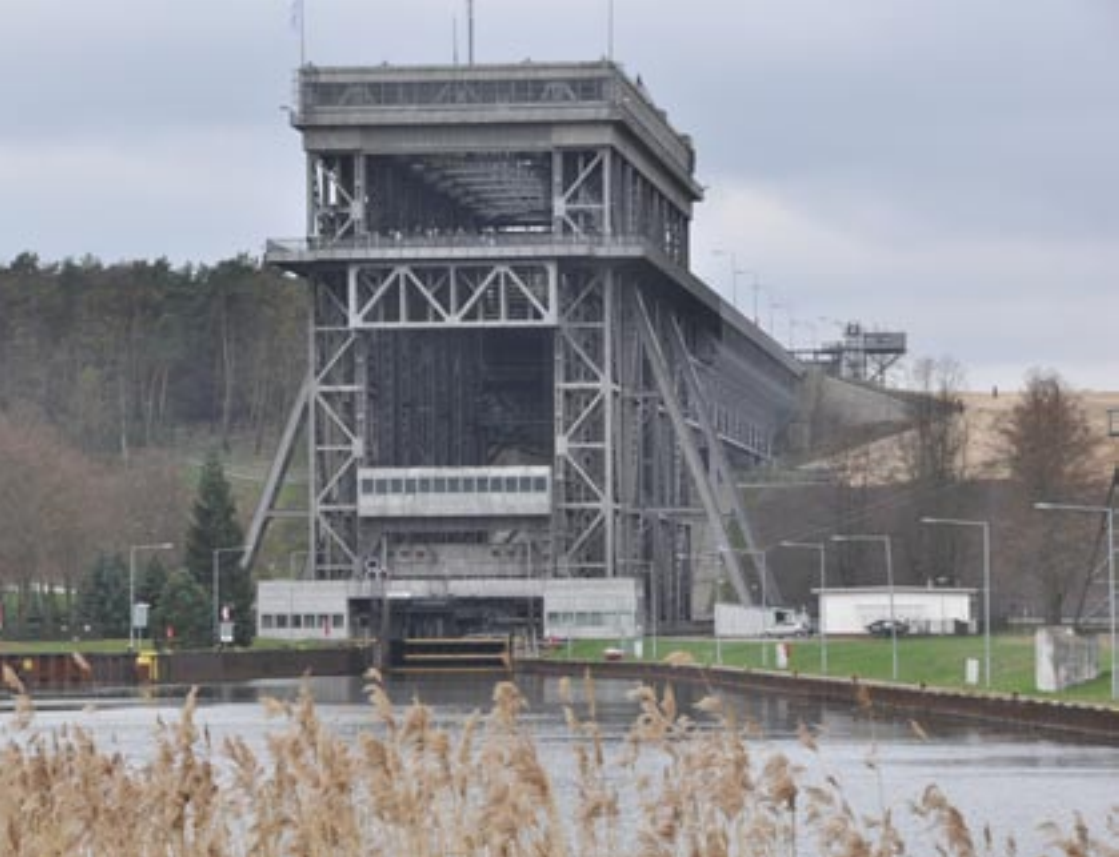
Über 75 Jahre alt, aber immer noch beeindruckend: das Schiffshebewerk Niederfinow am Oder-Havel-Kanal, das Schiffe 36 Meter in die Höhe hebt oder zu Tal lässt.
