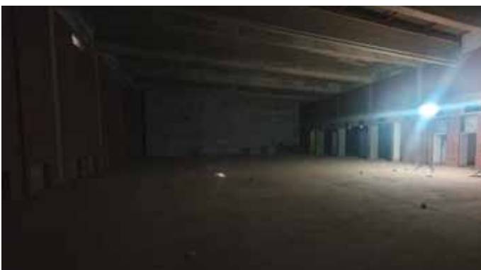
Zweifachturnhalle vor der Baumaßnahme (© Stadt Schleiden)
