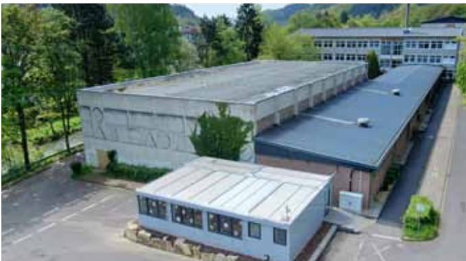
Schulzentrum Schleiden vor Beginn der Baumaßnahme. (© Stadt Schleiden)
