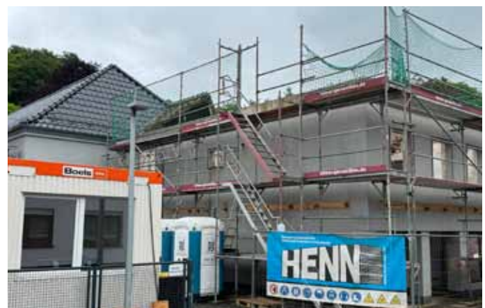
Das Gebäudeinnere wurde vollständig entkernt. Mit Rohbauarbeiten wurde im April begonnen. (© Architekturbüro abph)
