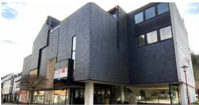
Ansicht des ehemaligen OSE-Komplexes von der Dreibröner Straße aus gesehen. (© Kerstin Wielspütz / Stadt Schleiden)
