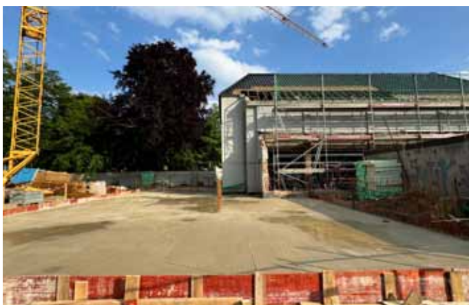
Die Bodenplatte des Erweiterungsbaus wurde Anfang Juni gegossen. (© Kerstin Wielspütz / Stadt Schleiden)
