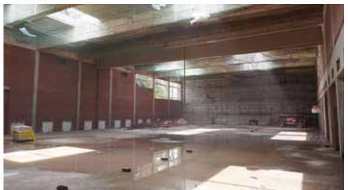
Zweifachturnhalle innen während der Baumaßnahme (© Stadt Schleiden)
