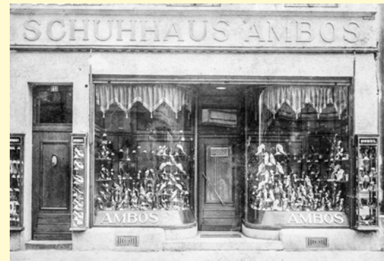
Das ehemalige Schuhhaus Ambos in der Sechzigstraße 4a
