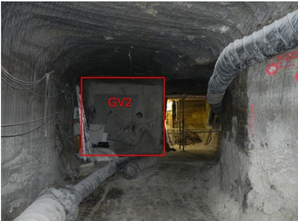
**Abb. 2** Luftseite des Bauwerkes GV2 mit dem seitlich aufgefahrenen Hohlraum zum Freilegen der Mantelfläche aus MgO-Spritzbeton [MgO-S<sup>3</sup>]
