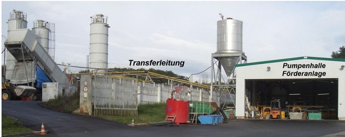
**Abb. 1** Transportbetonwerk, Transferleitung und Halle, in der sich die stationäre Förderanlage befand
