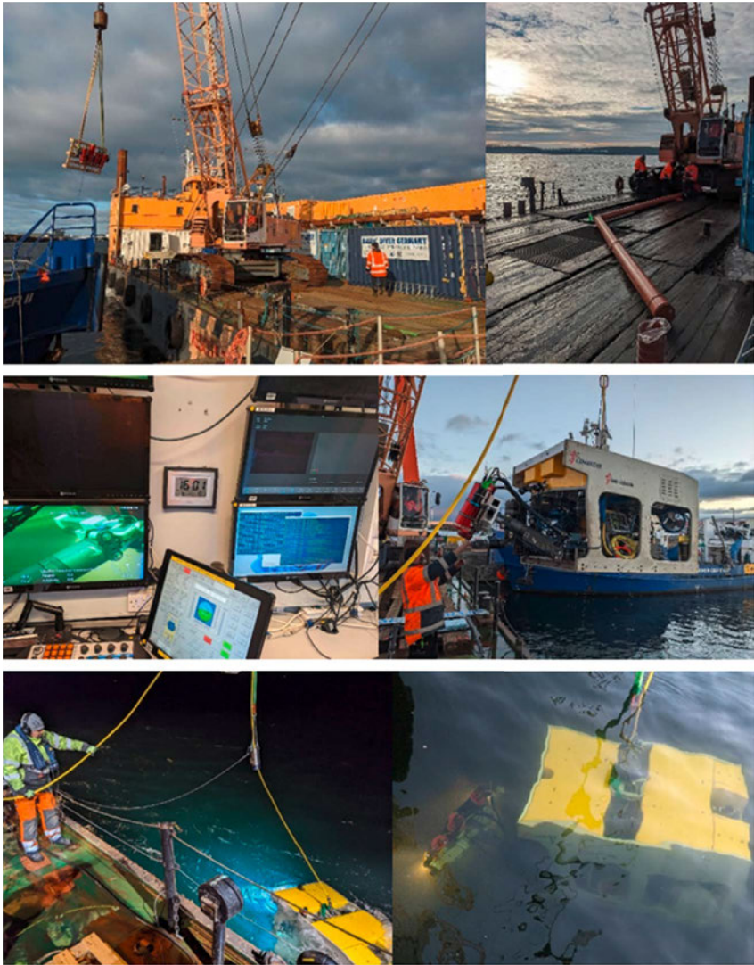
Abb. 12: Fotos vom Unterwassereinsatz
