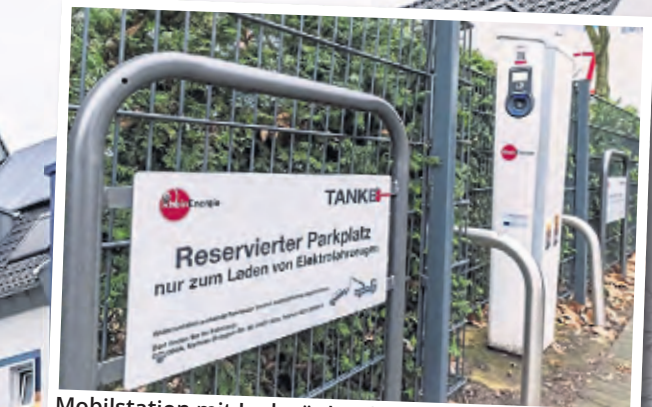
Mobilstation mit Ladesäulen für E-Autos. Die Ladesäulen werden durch die Solarzellen auf den Dächern der Wohnsiedlung mit Strom versorgt. Foto: Roll
