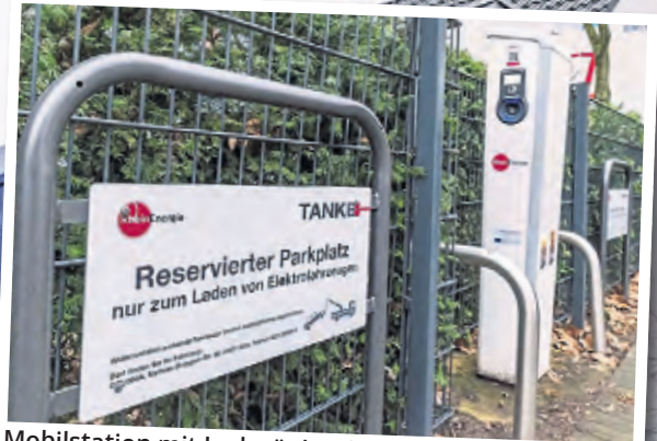
Mobilstation mit Ladesäulen für E-Autos. Die Ladesäulen werden durch die Solarzellen auf den Dächern der Wohnsiedlung mit Strom versorgt. Foto: Roll
