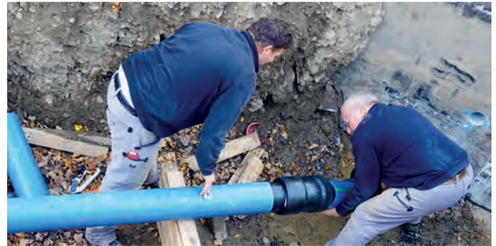
Bild 7: Für die Verlegung der SIMONA® Druckrohrleitungen sind verschiedene lokale Baufirmen im Einsatz. Dank des geringen Eigen gewichtes, selbst bei großen Rohrlängen, sind die Leitungen schnell und effizient verbaut.
