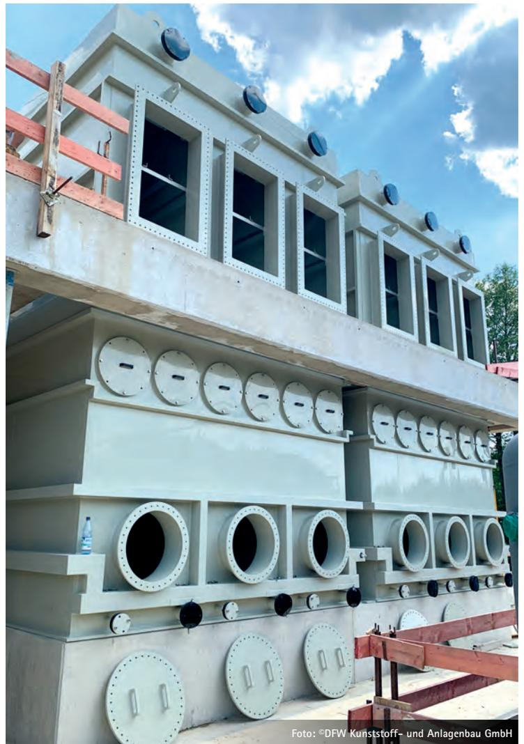
Bild 4: Installation von zwei Rieselkaskaden aus SIMONA® PP-H AlphaPlus® Platten.
