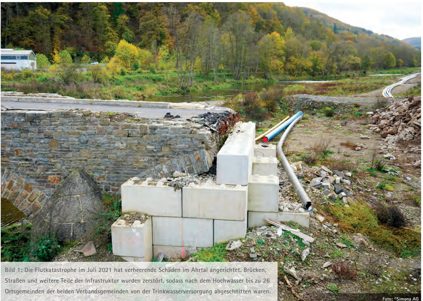
Bild 1: Die Flutkatastrophe im Juli 2021 hat verheerende Schäden im Ahrtal angerichtet. Brücken, Straßen und weitere Teile der Infrastruktur wurden zerstört, sodass nach dem Hochwasser bis zu 26 Ortsgemeinden der beiden Verbandsgemeinden von der Trinkwasserversorgung abgeschnitten waren.
