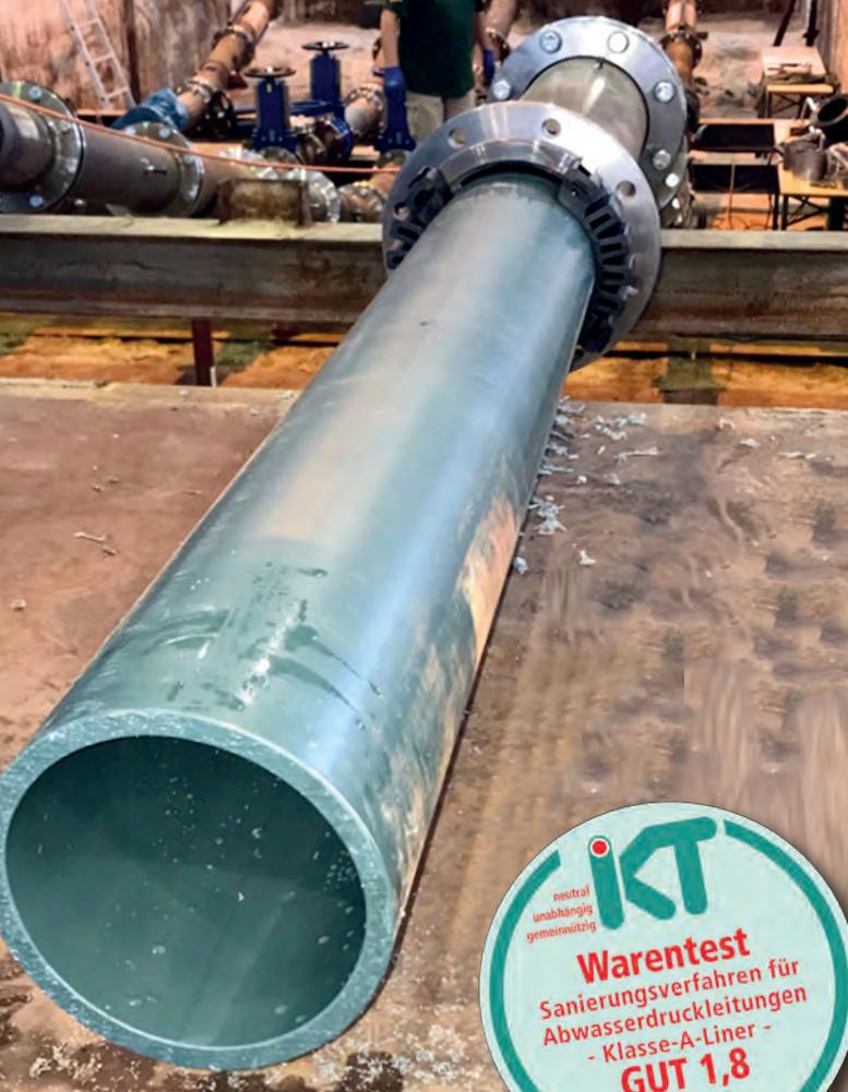
Bild 1: Klasse A Liner: Compact Pipe, DN 200, Installation in eine Dükerröhrlleitung beim IKT.
