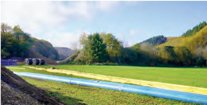
Bild 6: Die PE 100 SPC RC-Line Trinkwasserdruckrohre und die Gasdruckrohre sind mit einem zusätzlichen äußeren Schutzmantel aus modifiziertem Polypropylen ausgestattet. Dieser schützt das innenliegende PE 100 RC-Line Rohr vor mechanischen Beschädigungen.
