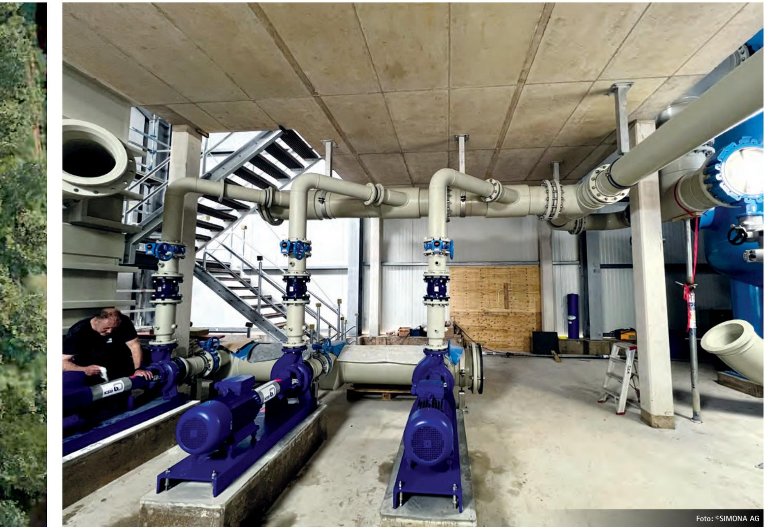
Bild 2: Rohwasser/Filtrat: Verrohrung aus SIMONA® PP-H AlphaPlus®.
