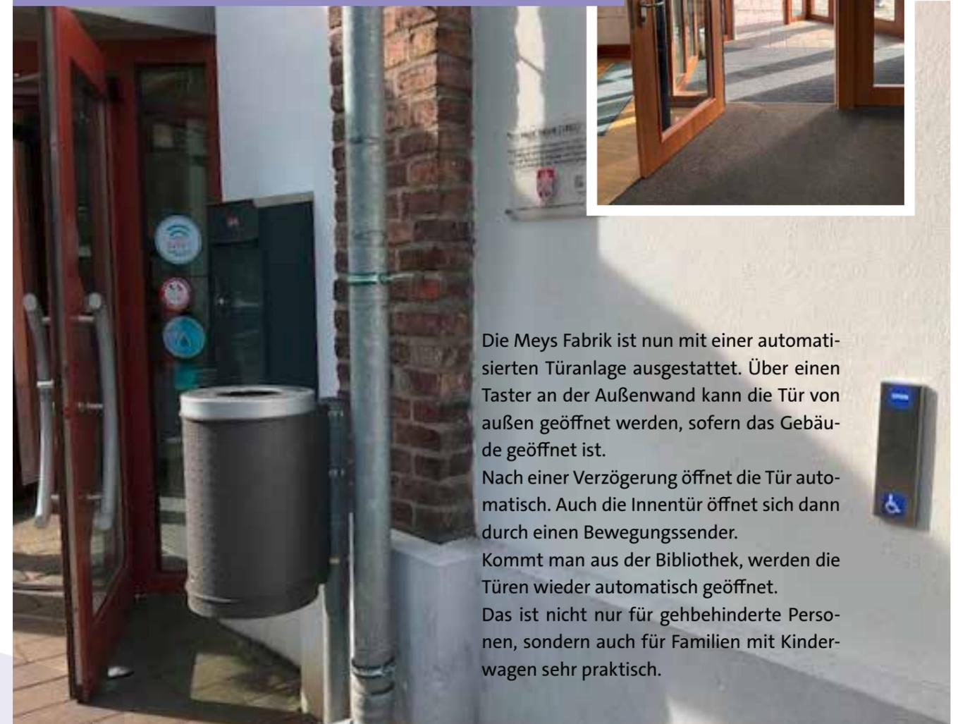
Die Meys Fabrik ist nun mit einer automatisierten Türanlage ausgestattet. Über einen Taster an der Außenwand kann die Tür von außen geöffnet werden, sofern das Gebäude geöffnet ist.
