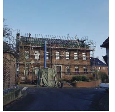
Die Alte Schule in Boslar wurde mithilfe von Fördergeldern erweitert.
