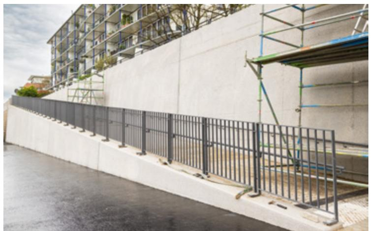
**Oben:** Fertiggestellte betonierte Vorsatzschale in je 9 m breiten und 6 m hohen Blöcken. Verbreiteter Geh- und Radweg (4 m Breite) aus Gussasphalt / Böschungssicherung aus einbetonierten Wasserbausteinen / © StEB Köln
