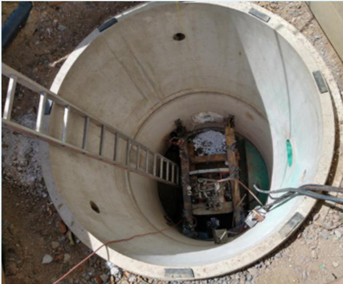
Startgrube Pilotrohrvortrieb für Kanalquerung Frankfurter Straße
