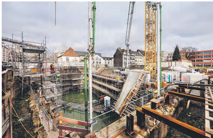
Kein leichtes Unterfangen: Mithilfe von Betonpumpen wurde das Material in die unterste Bauwerksebene in rund 26 Metern Tiefe eingebracht. Kleines Bild oben: Techniker überwachten den Betonierorgang. Kleines Bild unten: Betonmischfahrzeuge aus Pulheim, Eschweiler und Hürth lieferten die benötigte Betonmenge an die Baustelle
