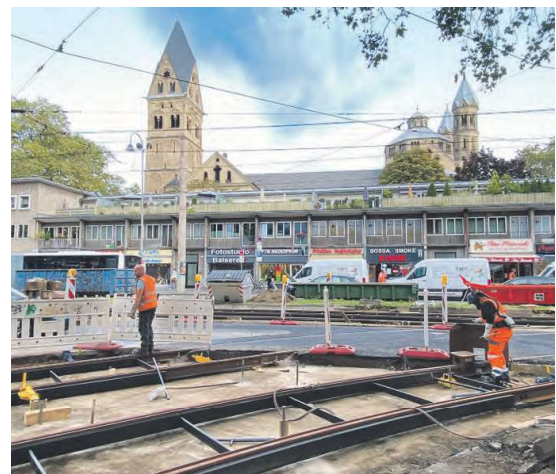
Wie hier auf dem Abschnitt zwischen Rudolfplatz und Neumarkt waren Bauteams im ablaufenden Jahr bei umfangreichen Maßnahmen im Einsatz
