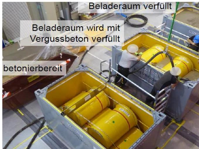
**Abb. 2.22** Betonierung KC III mit 5 x 400-I-Fässer /GNS 20/
