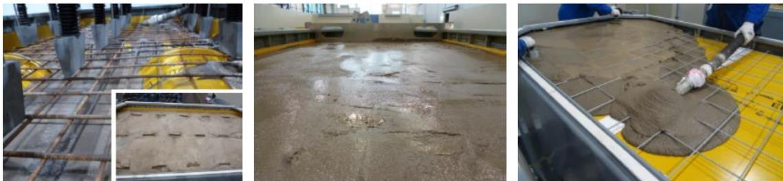
**Abb. 2.21** Niederhaltung der Fässer (links), Vergussbeton mit Abziehlehre (mittig) und Einbringen Abschlussbeton (rechts) /GNS 20/
