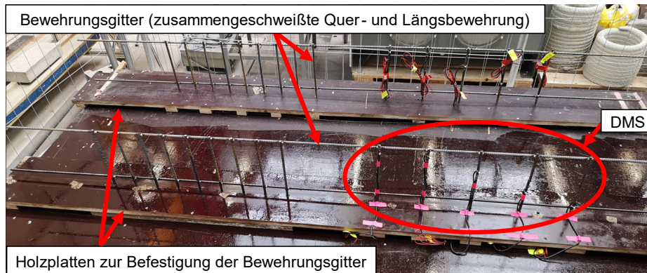
Bild 4.67: Holzplatten zur Positionierung der Querkraftbewehrung
