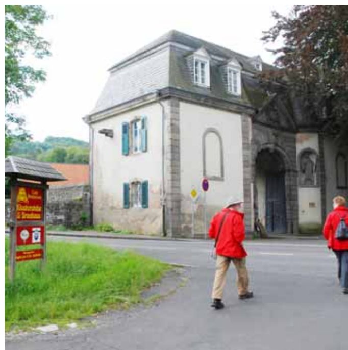
Torbäude der Klosteranlage
