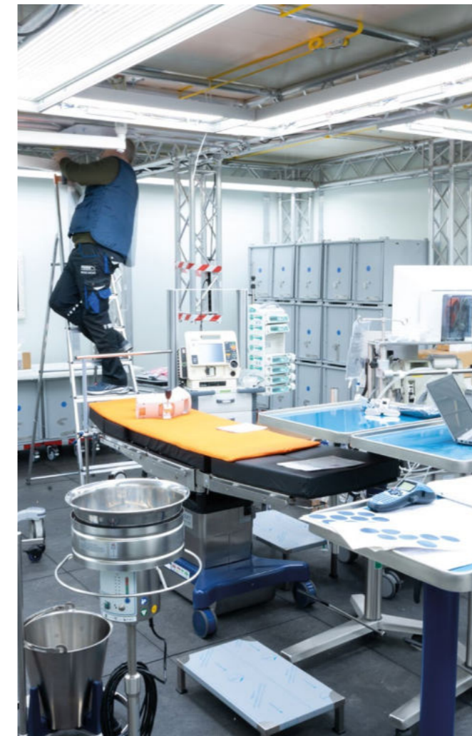
Die MOHKI wird eingerichtet.
