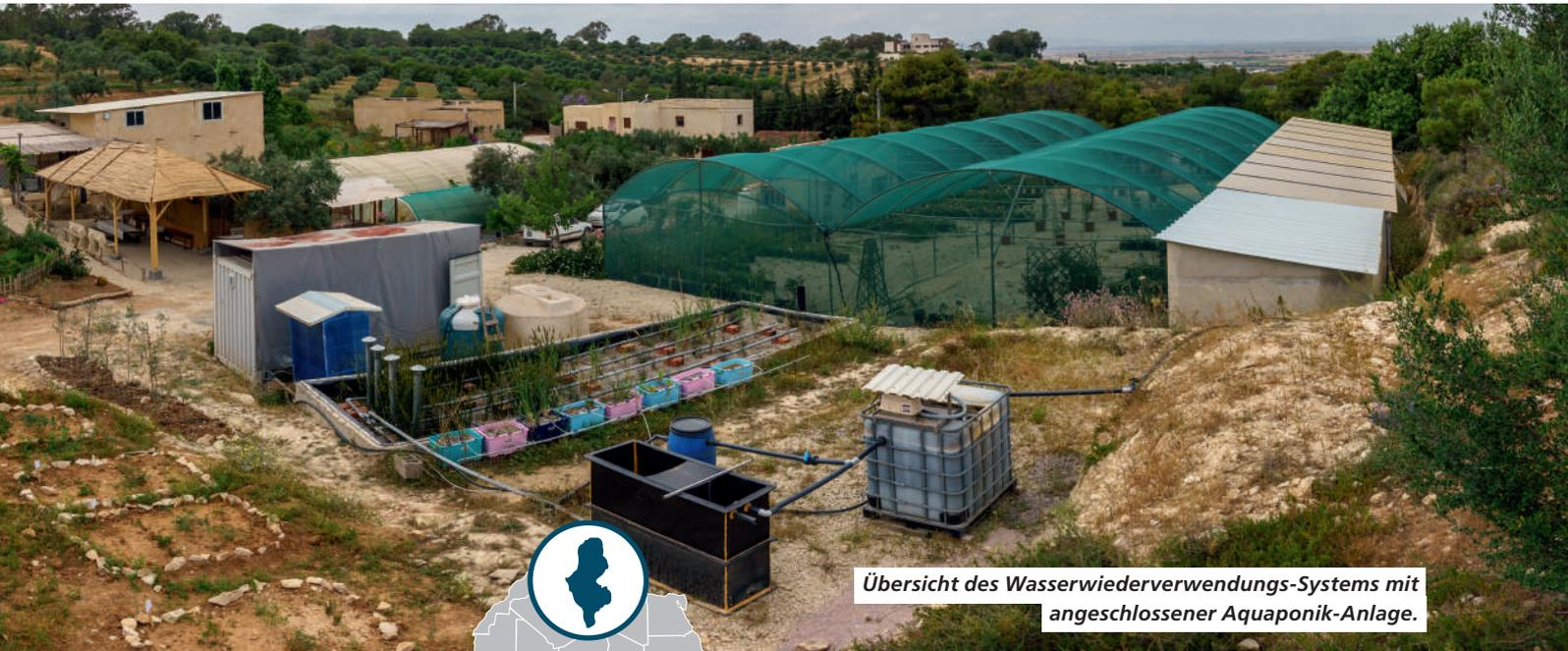
Übersicht des Wasserwiederverwendungs-Systems mit angeschlossener Aquaponik-Anlage.
