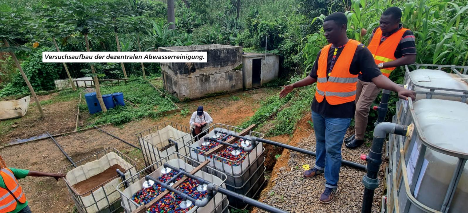
Tropfkörper-Reaktor mit Plastikdeckel-Füllmaterial.
