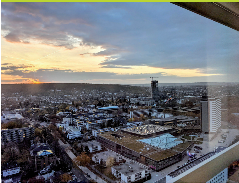
Blick vom VN-Campus Bonn auf das alte Regierungsviertel mit dem World Conference Center
