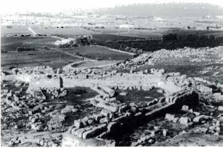
Abb. 6: Projekt „Syrakus – die Mauern Dionysios I.“ Syrakus gilt als größte Befestigungsanlage der griechischen Welt: Blick vom Euryalos auf Tripylon, Nordmauer und nördliche Küstenebene.
