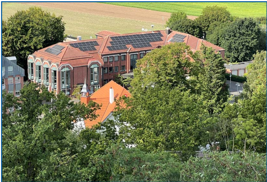
Neue Photovoltaikanlage am Rathaus der Stadt Wassenberg
