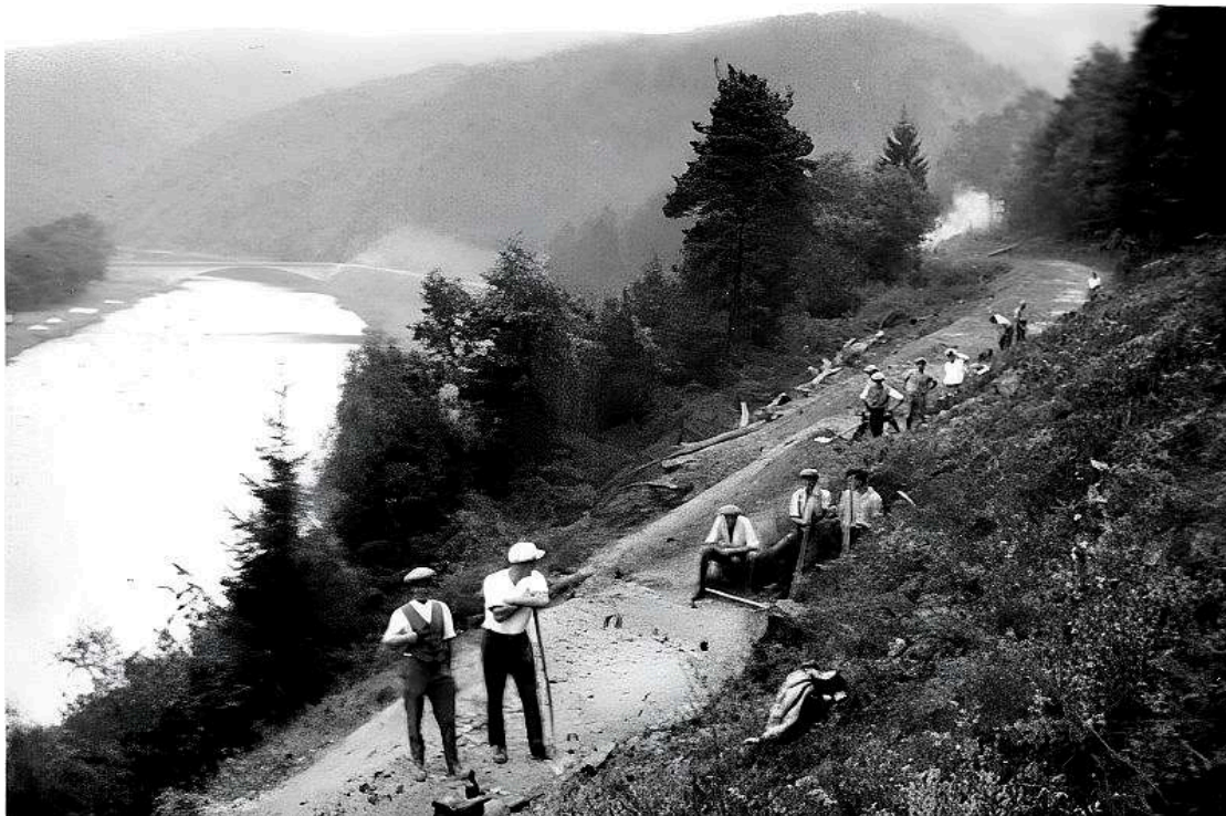
Arbeiter während des Straßenbaus
