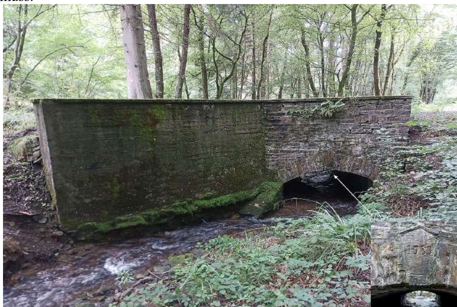
Brücke über den Mühlenbach mit eingeschlagenem Erbauungsjahr
