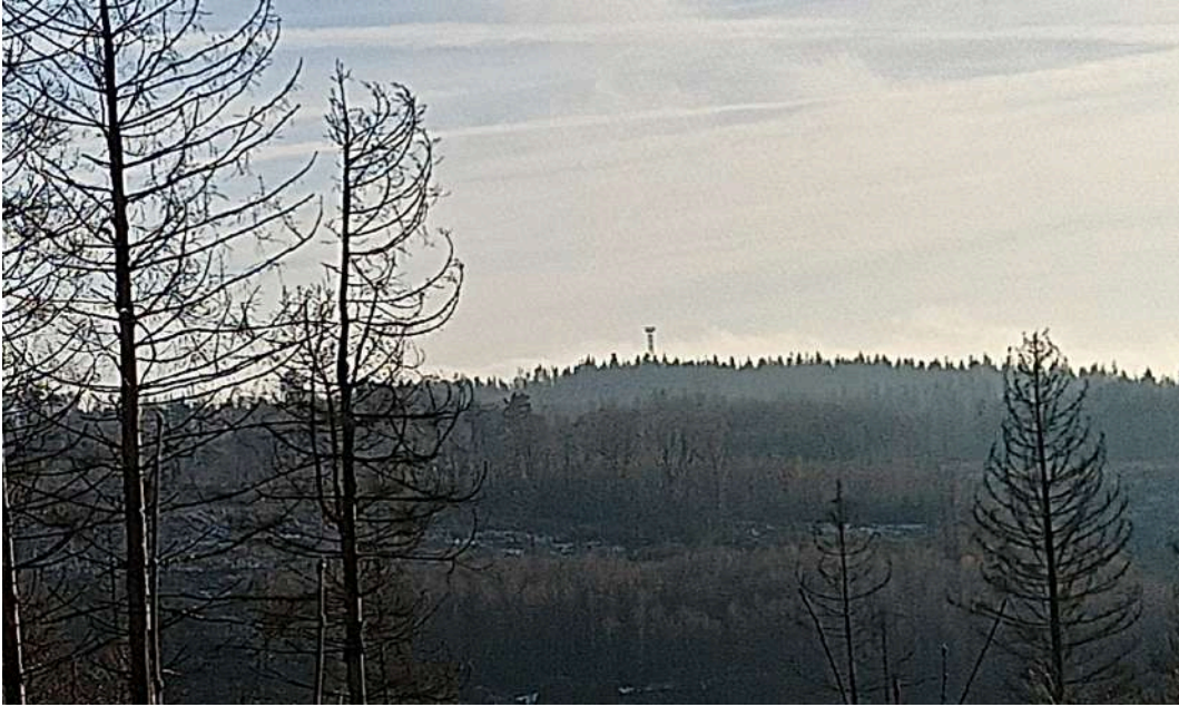
Der fertige Mast im Dezember 2023
