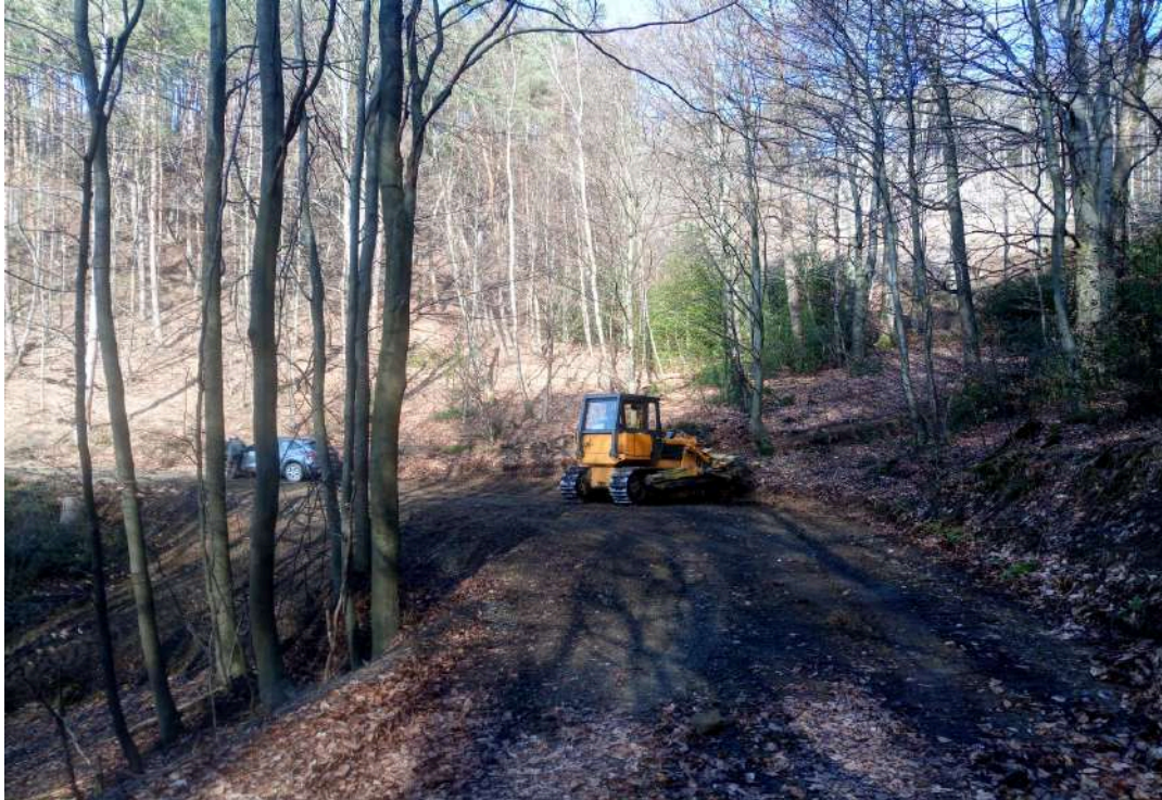
Eine im Wegebau eingesetzte Planierdraupe im Grundsberg, unterhalb der Hängenhardt
