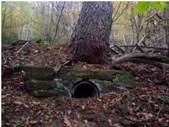
Bachunterführung – Zustand bei Entdeckung und nach der Freilegung
