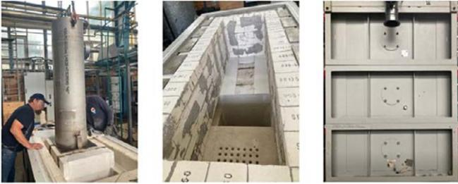
Umbau des Technikumsreaktors. Neue Ausmauerung und neuer Rohrofen inkl. neuer Messtechnik für das Festbettreaktorprojekt.
