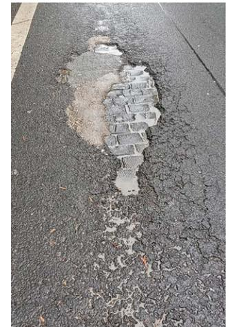
Beispiele für Straßenschäden: Rissbildung in der Deckschicht und Ablösung der Fahrbahndecke (wg. mangelnder Adhäsion)
