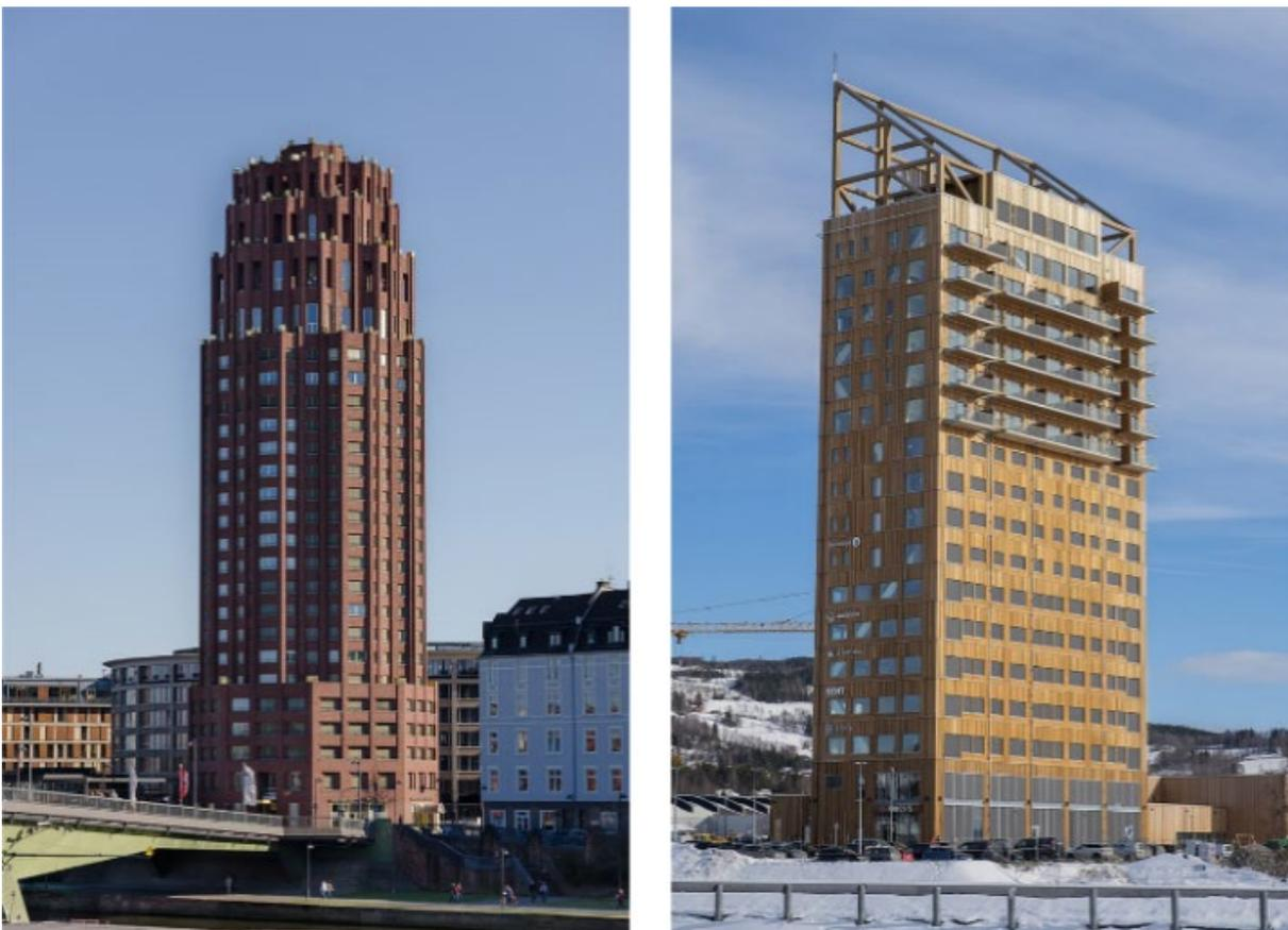
Abbildung 5: Hochhäuser aus Stahlbeton in Frankfurt a. M. (links) sowie aus Holz (Mjøstårnet) in Brumunddal, Norwegen (rechts)
