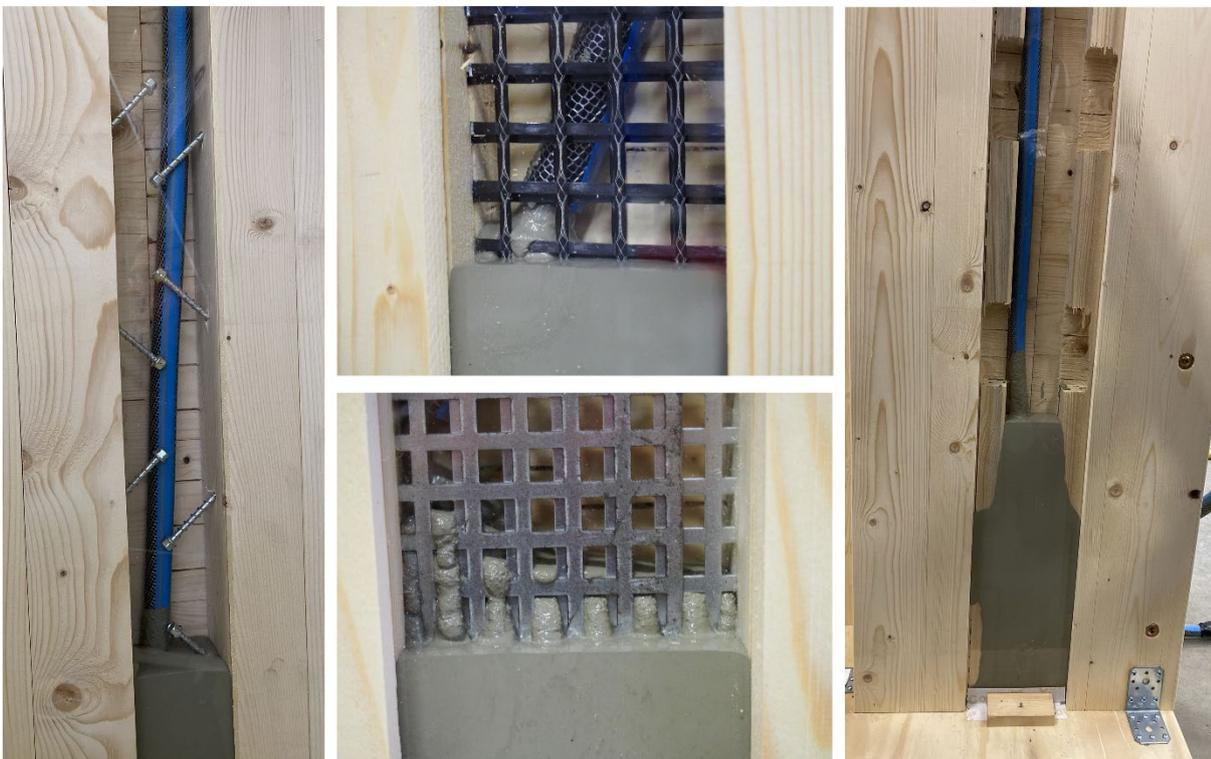
Abbildung 21: Verbindungsvarianten in Nut während des Betonierens mithilfe eines an die Betonpumpe angeschlossenen Schlauchs
