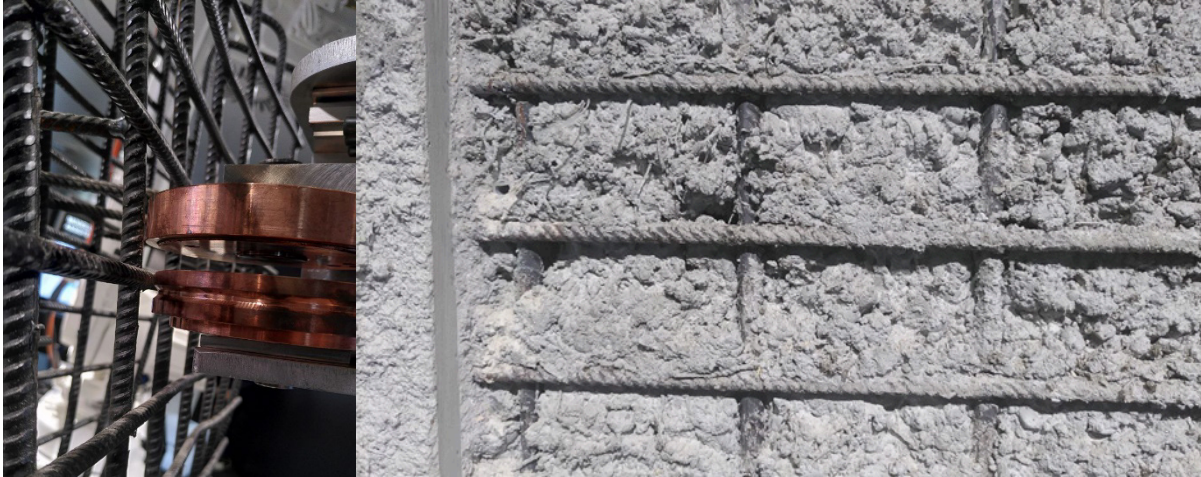
Abbildung 1: Schweißelektrode und Bewehrungsverbundzone des Meshmould-Verfahrens.
