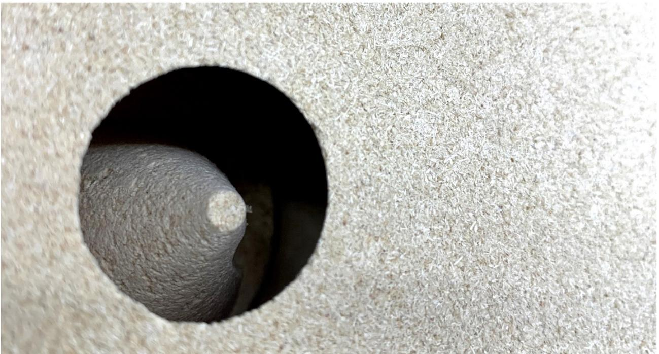
Abb.64: Detailaufnahmen von Resonatoren
