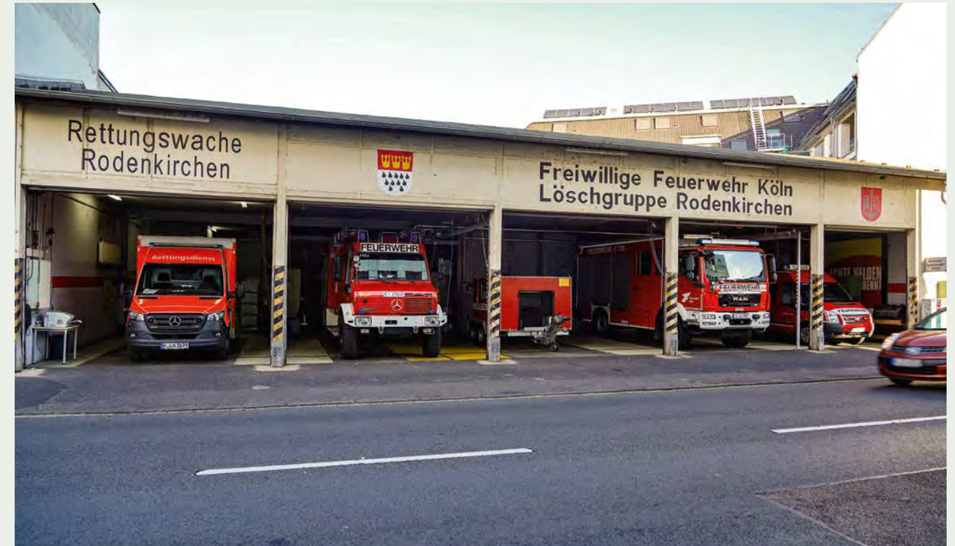
Die aktuellen Räumlichkeiten in der Schillingsrotter Straße sind in sehr schlechtem Zustand.
