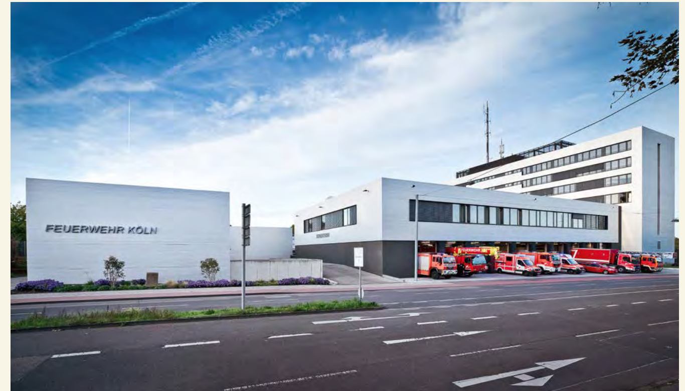
Die Räumlichkeiten der Feuer- und Rettungswache 5 befinden sich direkt über der Fahrzeughalle.
