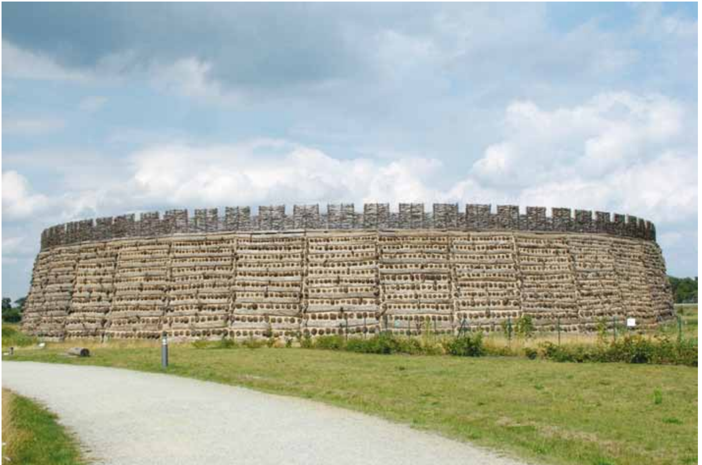
Rekonstruktion der ehemaligen Slawenburg | Raddusch / Brandenburg
