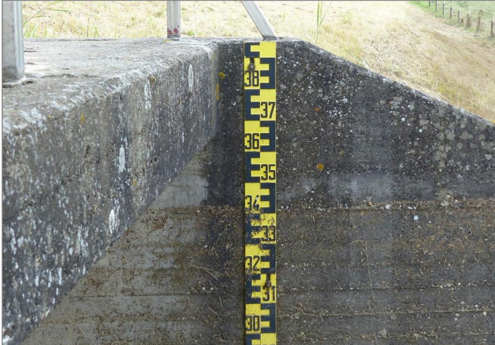
Abb. 1-2: Maximaler Wasserstand im HRB Sinthern: 3,4 m (Foto: Engel)
