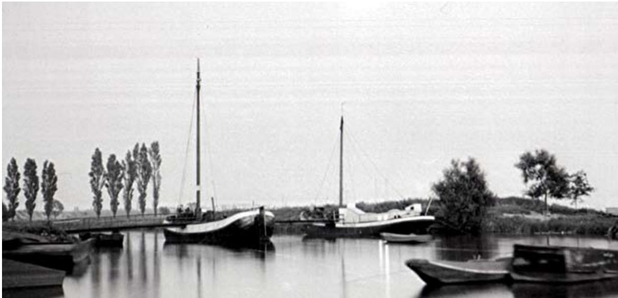
*Nach 1956 kaufte Heinrich Gless nacheinander drei holländische Schiffe und nutzte sie als Tragkörper für die Steganlage. Das Bild zeigt die Schiffsbrücke vor Kauf des Aalschokkers. Foto: privat*
