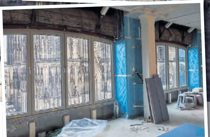
Projektleiter Miguel Espinosa (Foto oben) führte über die Baustelle und zeigte, dass die historische Treppe (Foto Mitte) erhalten blieb. Der exklusive Blick aus dem Hotelfenster zeigt, dass der Dom zum Greifen nah ist. Fotos: Bause
