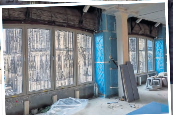
Projektleiter Miguel Espinosa (Foto oben) führte über die Baustelle und zeigte, dass die historische Treppe (Foto Mitte) erhalten blieb. Der exklusive Blick aus dem Hotelfenster zeigt, dass der Dom zum Greifen nah ist. Fotos: Bause
