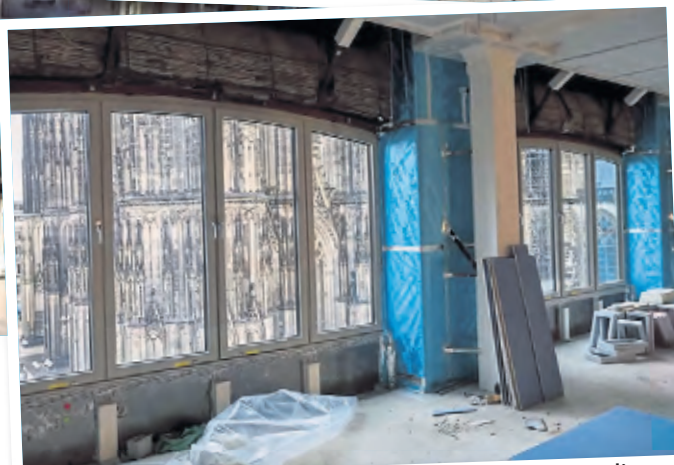
Projektleiter Miguel Espinosa (Foto oben) führte über die Baustelle und zeigte, dass die historische Treppe (Foto Mitte) erhalten blieb. Der exklusive Blick aus dem Hotelfenster zeigt, dass der Dom zum Greifen nah ist. Fotos: Bause
