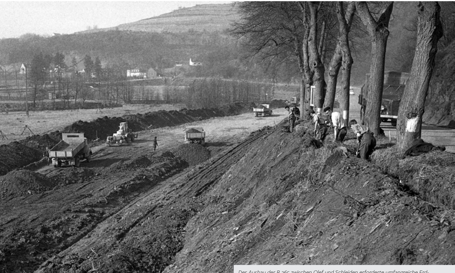
Der Ausbau der B 265 zwischen Olef und Schleiden erforderte umfangreiche Erdarbeiten. Durch die Verlegung der Straßentrasse wurden an der Hangseite Flächen frei für die Anlegung eines Parkplatzes sowie eines Radfahr- und Fußgängerweges.
