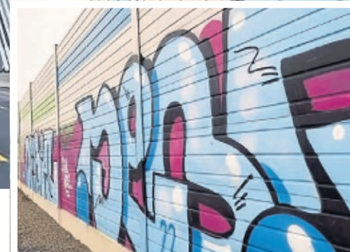
Graffiti an der Schutzwand. Foto: Trzeciak
