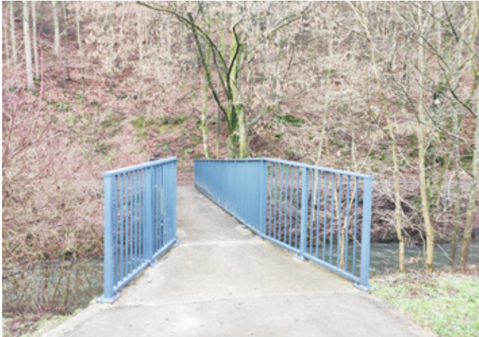
Das neue Geländer wurde an der Brücke im Kurpark angebracht, so dass die Querungshilfe wieder nutzbar ist. Foto: E. Schwarz
