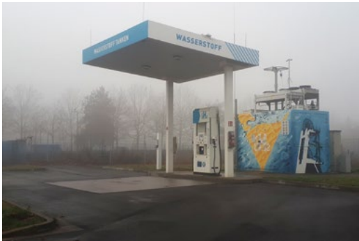
Wasserstofftankstelle in Herten
