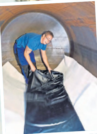
Mit einer neuen Innenhülle lässt sich der alte Heizöltank als Wasserspeicher nutzen.
