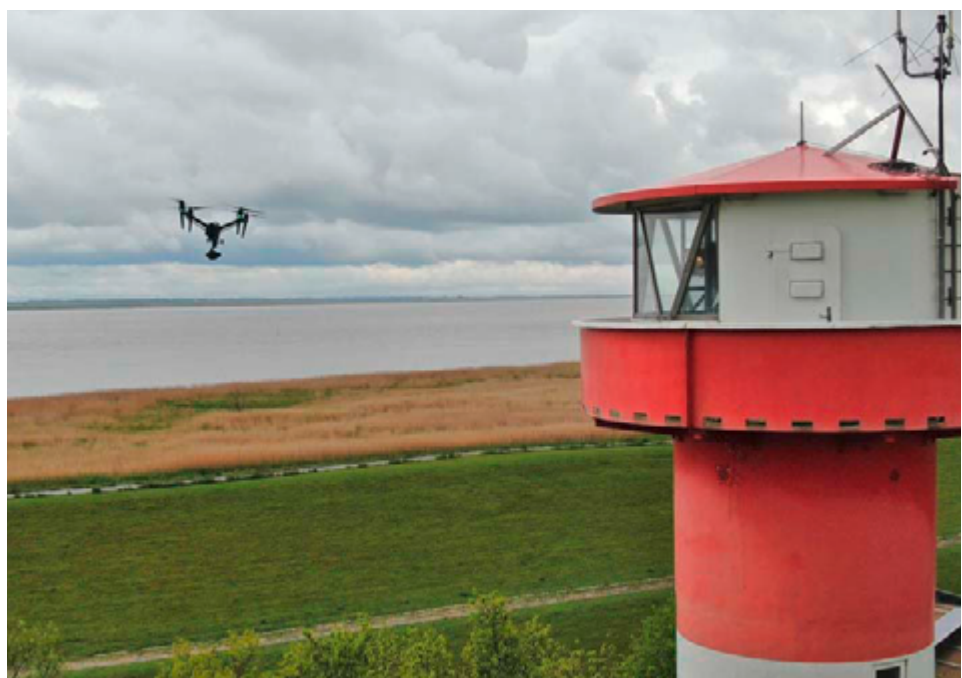
Bauwerksinspektion eines Leuchtf Feuerträgers
