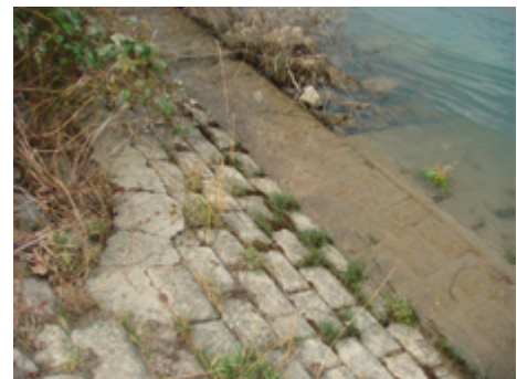
... und dem stark verbauten, teilweise gepflasterten Deckwerk
