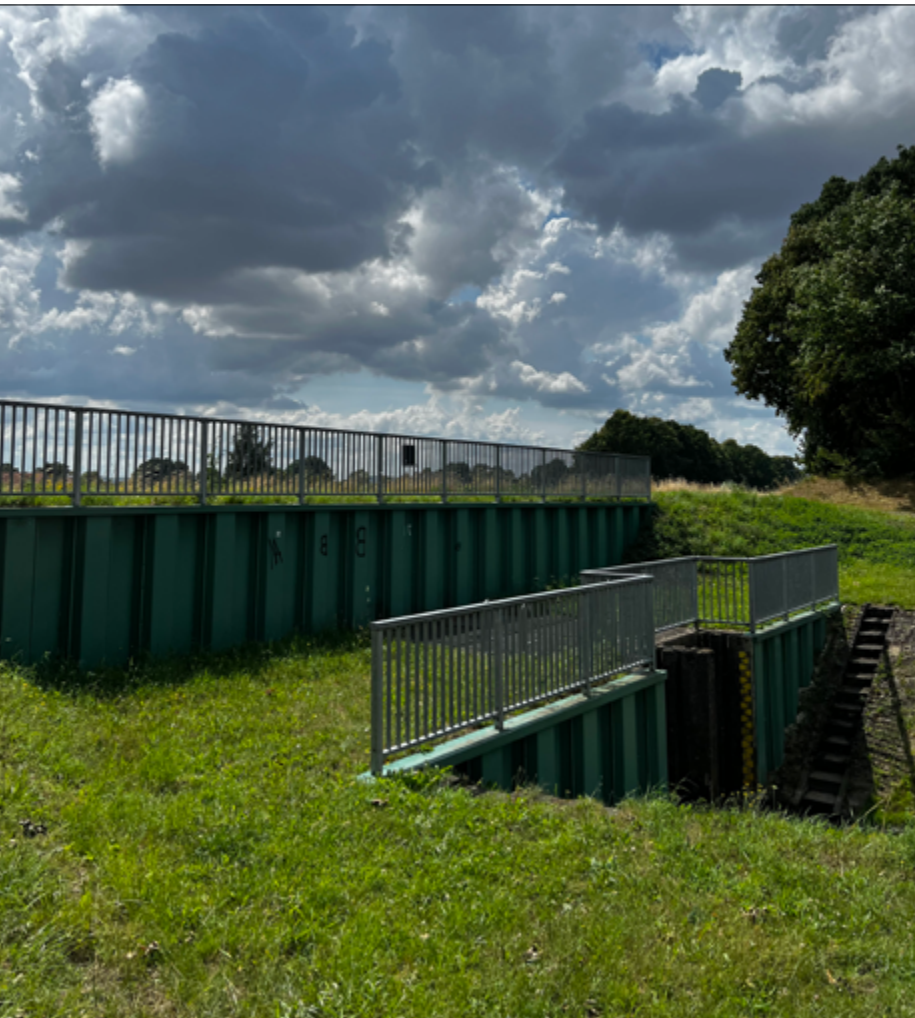
Der Ein- oder Auslauf eines Dükers
