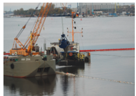
Verbringung des schadstoffhaltigen Schlicks durch einen Trichter in die Dockgrube
