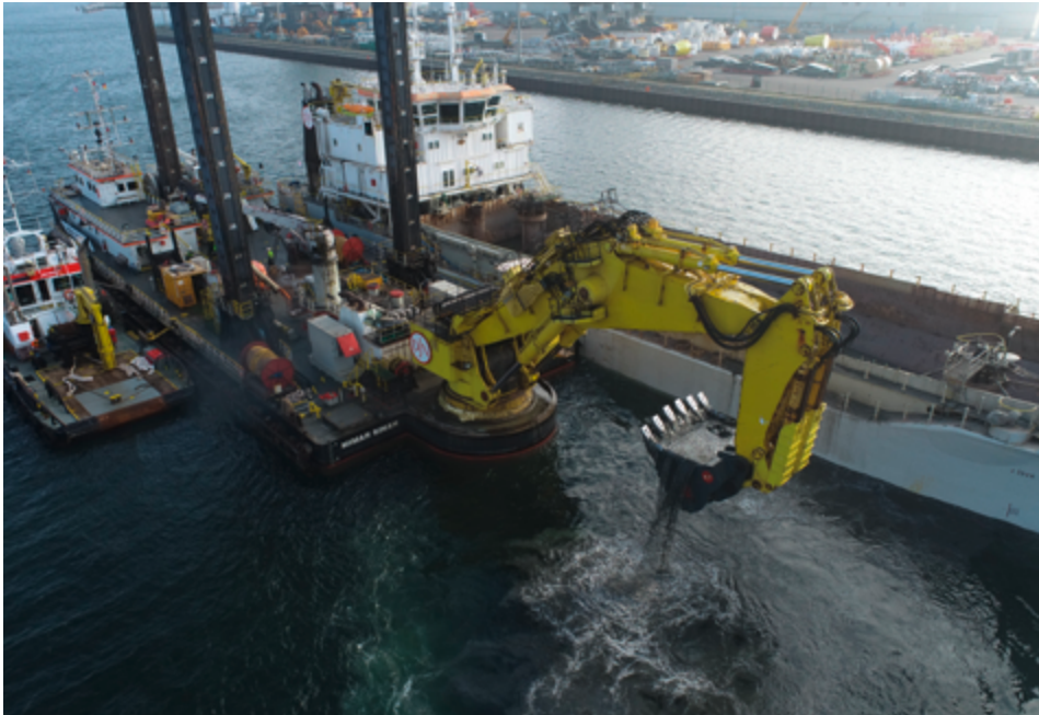
Der Stelzenbagger MIMAR SINAN beim Ausbaggern des Seekanals und Beladen einer Klappschute
