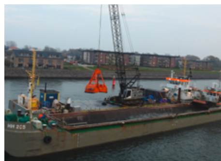
Baggerstift STEINBUTT mit Seilzugbagger im Verbund mit Schute HH 205
