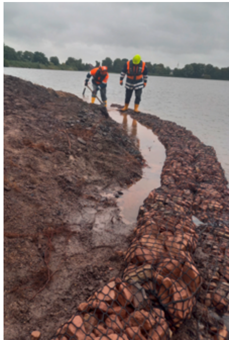
Einbau von Steinwalzen am Ufer eines Spülsees
