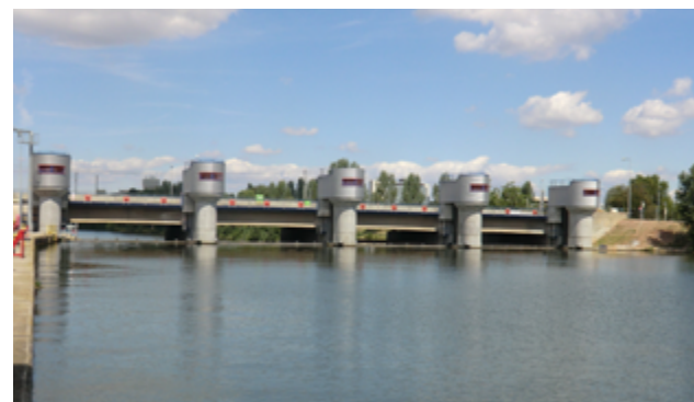
Gegenüberstellung – alte (oben) und neue (unten) Wehranlage Untertürkheim
