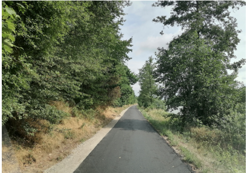
Laufende Maßnahme: fahrradtauglicher Ausbau des Betriebswegs am Main-Donau-Kanal
