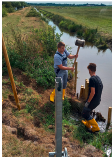
Setzen einer Pfahlreihe zum Beseitigen eines Uferabbruchs
