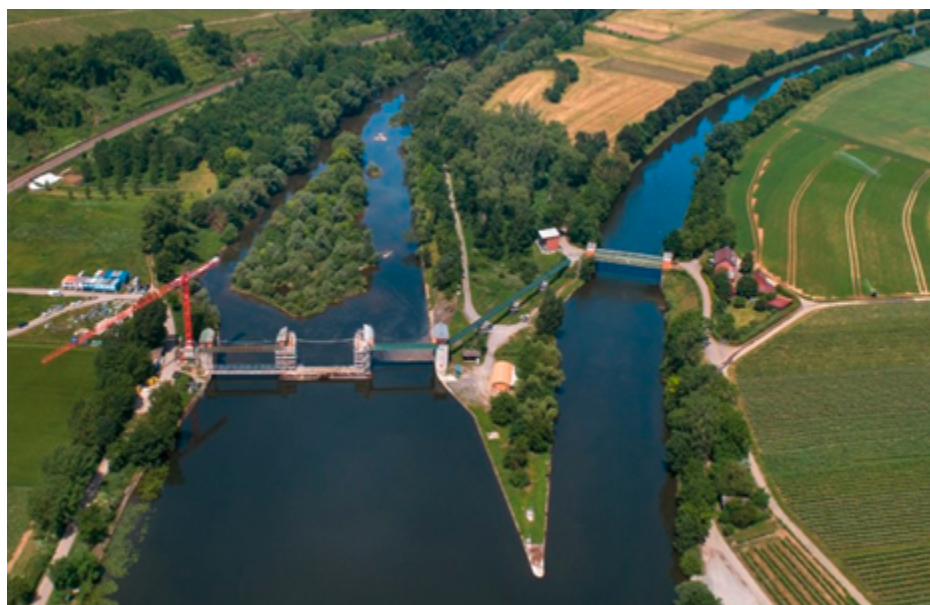
Grundinstandsetzung des Wehres Horkheim mit neuem, abgesetztem Technikgebäude – das rechte Wehrfeld ist fertiggestellt, das mittlere befindet sich im Bau
