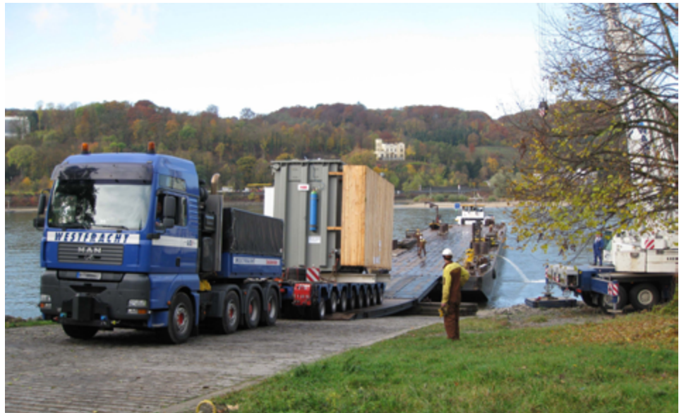
GST-RoRo-Umschlag am Rhein, EÜ Bad Honnef bei Rhein-km 640
