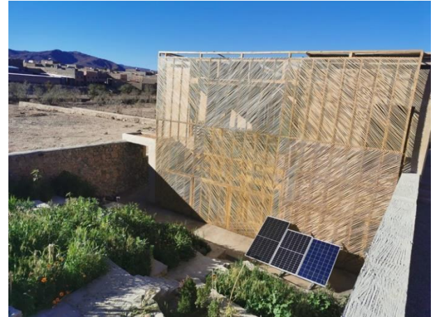
Foto 1: Energiezentrum Tata (Quelle: J. Seitz).
