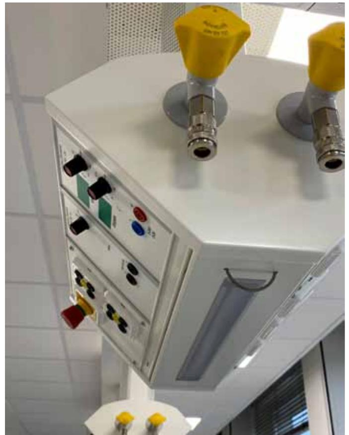
Das absenkbare Deckenversorgungssystem mit eingebauter dimmbarer Beleuchtung sowie Gas- und Stromanschlüssen ermöglicht eine große Bandbreite von Experimenten. (© Stadt Schleiden / Kerstin Wielspütz)
