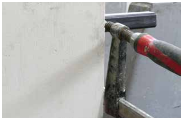
Abb. 123: Positionierung mit Schraubzwingen (ELO)
