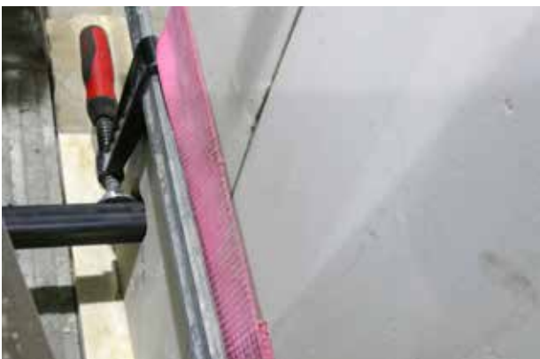
Abb. 122: Zum Schutz der Schalung: Gummimatten (ELO)
