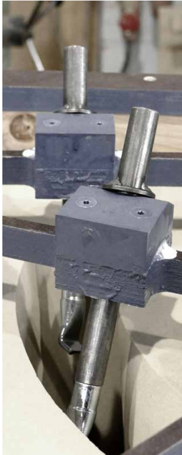
Abb. 125: Justierung der Schablone zur Implementierung der Verankerung (ELO)
