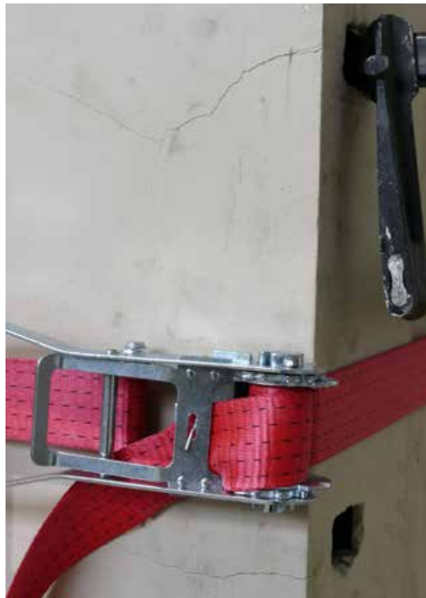
Abb. 121: Spanngurte fixieren die Schalungen in Position (ELO)
