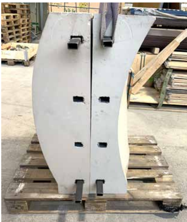
Abb. 119: Justierung der Schalungen zur Betonage (Runkel)
